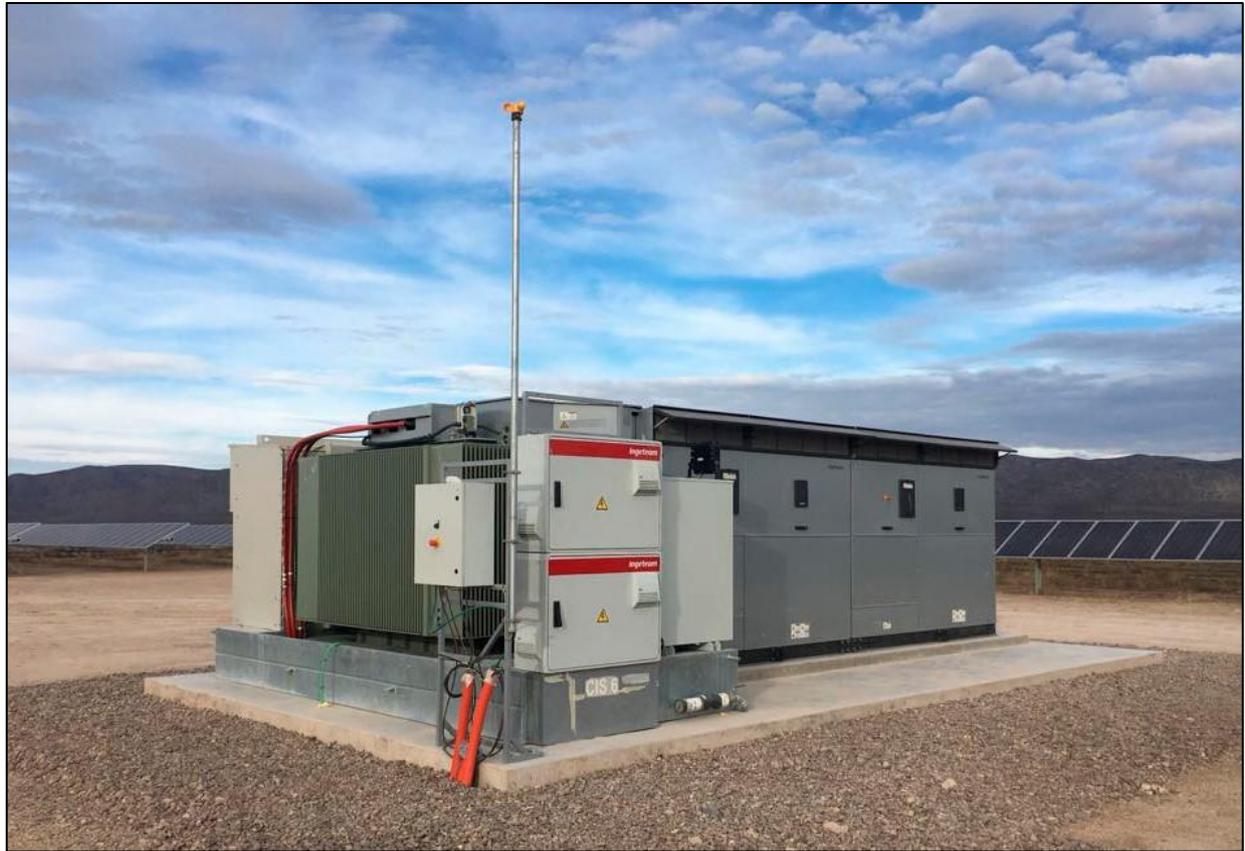
**Fig. 7: Cabine di trasformazione**
