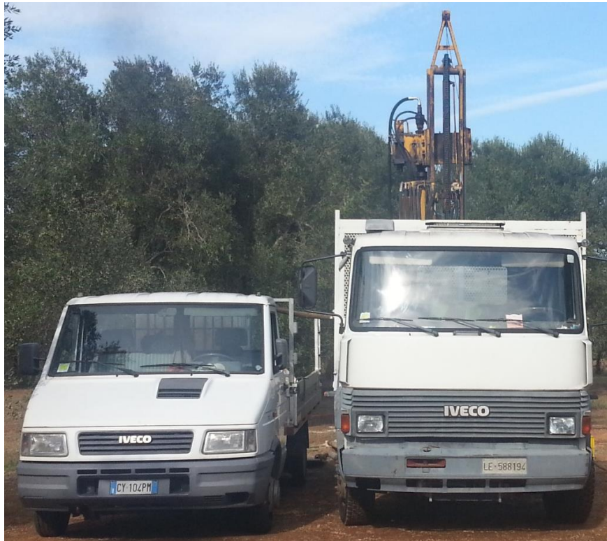
Postazione sondaggio S1
