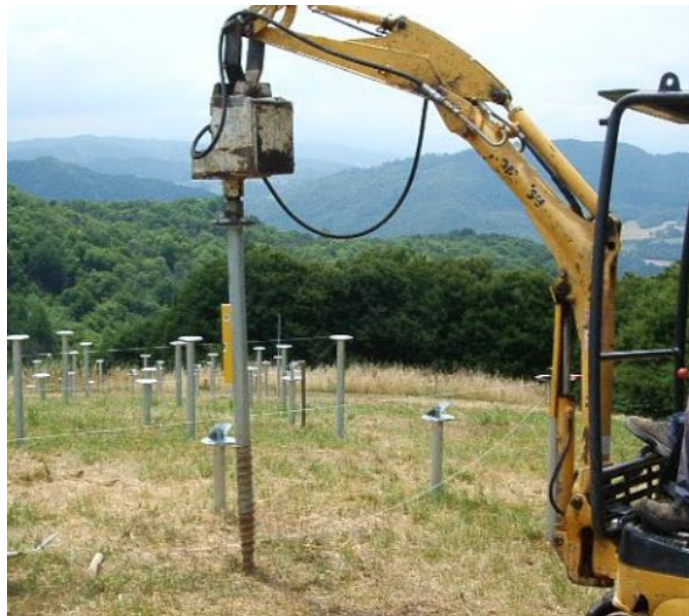
Figura 2: Sistema di ancoraggio al suolo denominato "T-Block"
