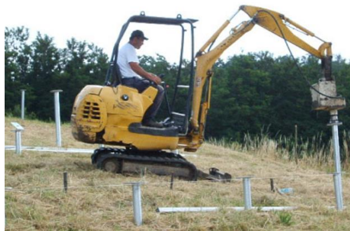
Figura 2: Sistema di ancoraggio al suolo denominato "T-Block"
