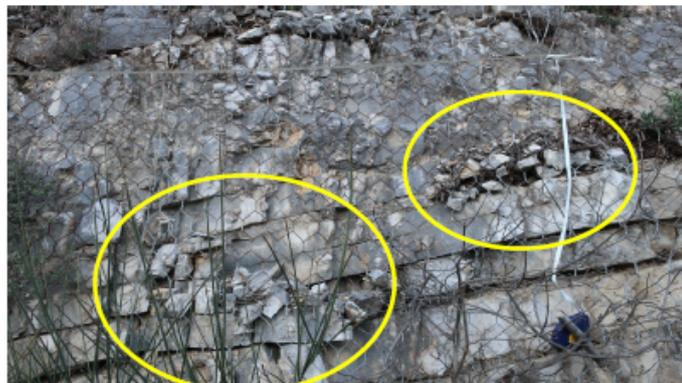
Figura 7: particolare della linea di scansione ST1, nei cerchi sono evidenziati i distacchi di blocchi centimetrici.
