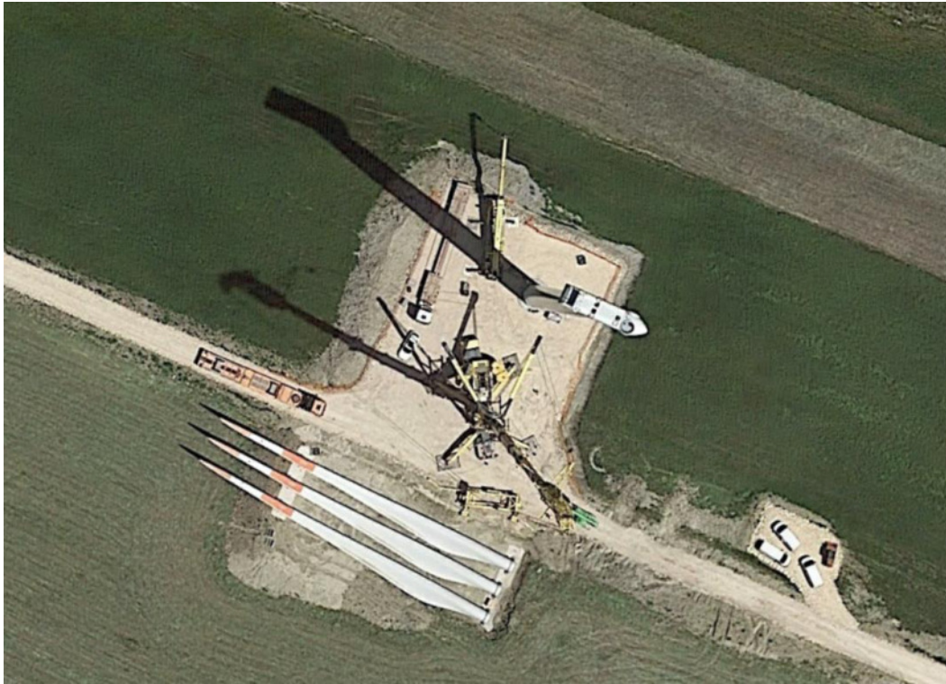
Figura 2.5 – esempio di piazzola in fase di costruzione
