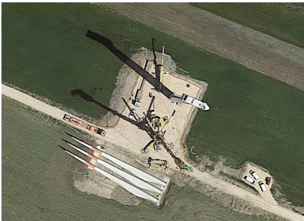
Figura 2.5 – esempio di piazzola in fase di costruzione
