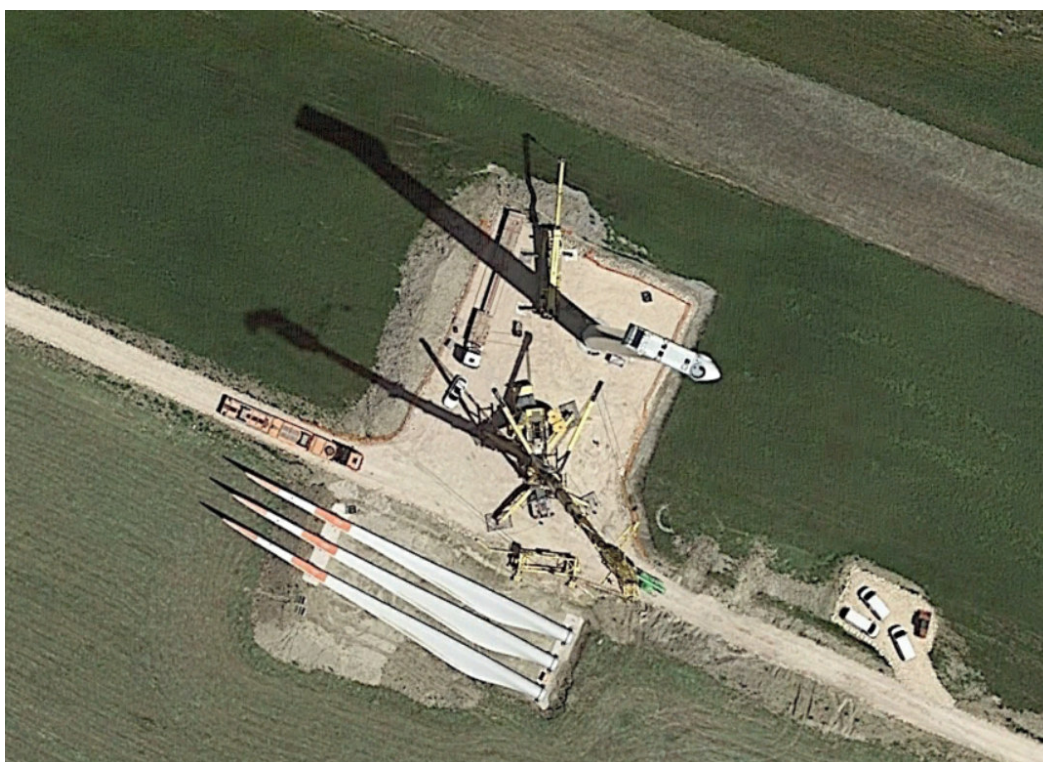
Figura 4.3: Esempio di piazzola in fase di costruzione
