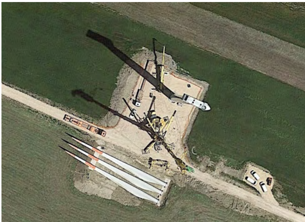
Figura 4.3: Esempio di piazzola in fase di costruzione.
