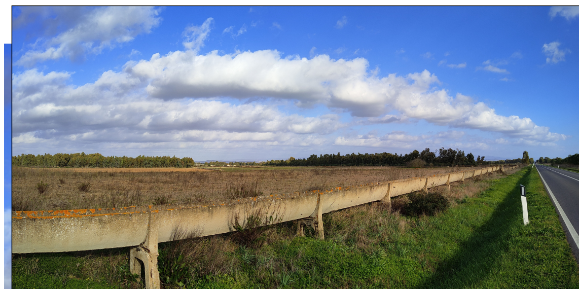
in alto – Foto 1 - Ripresa dalla Strada Statale 196 (KM 15+200) a circa 70 metri dai confini sud dell'area di impianto nel comune di Serramanna.
