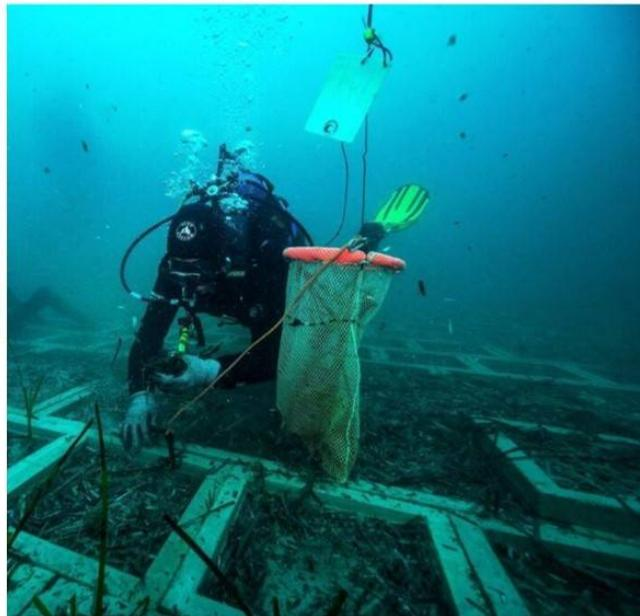
Figura 4.14 – Esempio di utilizzo di materassi zavorrati per interventi di reimpianto di Posidonia oceanica.
