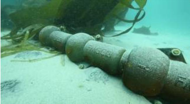
**Figura 4.16 – Esempio di posa con protezione in elementi modulari tubolari.**
