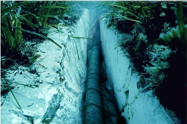
Figura 4.10 – Esempio di posa con tecnica di trenching chirurgico.
