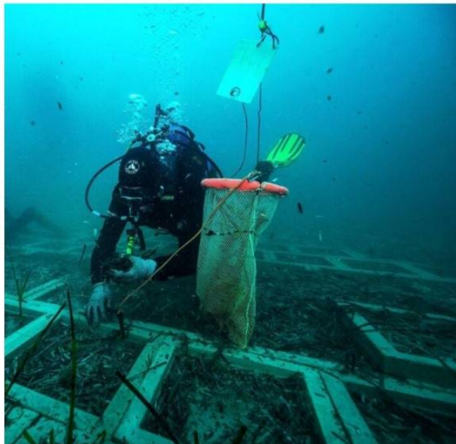
Figura 3.12 – Esempio di utilizzo di materassi zavorrati per interventi di reimpianto di Posidonia oceanica.
