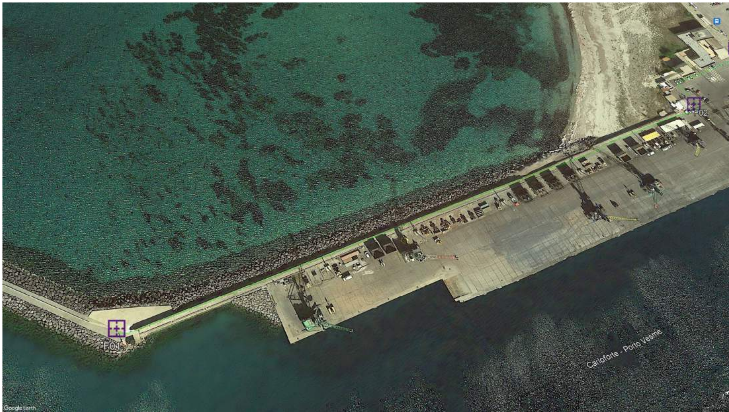
Vista 1: F01 punto di giunzione tra cavidotto marino e cavidotto terrestre nell'area portuale di Portovesme.
