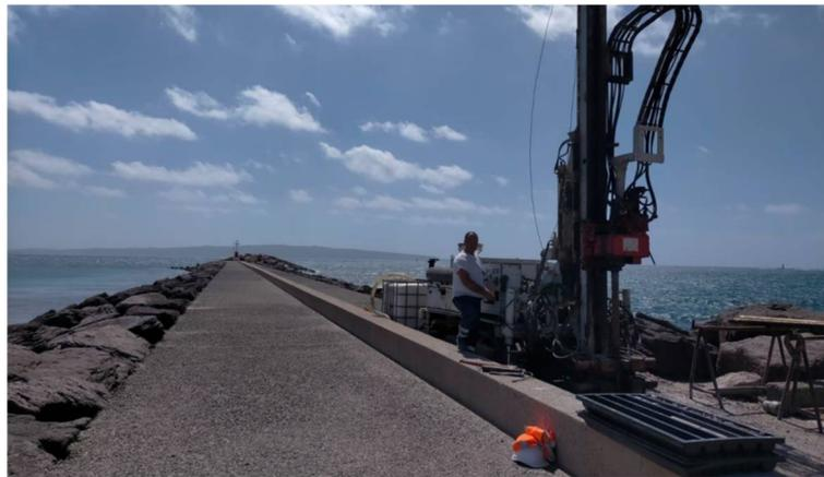
**Figura 4.4 – Esecuzione del Sondaggio 2 in corrispondenza del tratto iniziale della barriera frangiflutti.**
