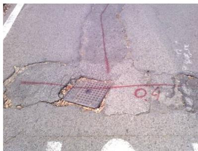
**Figura 6.3 – Indicazione dei sottoservizi esistenti mediante marker.**
