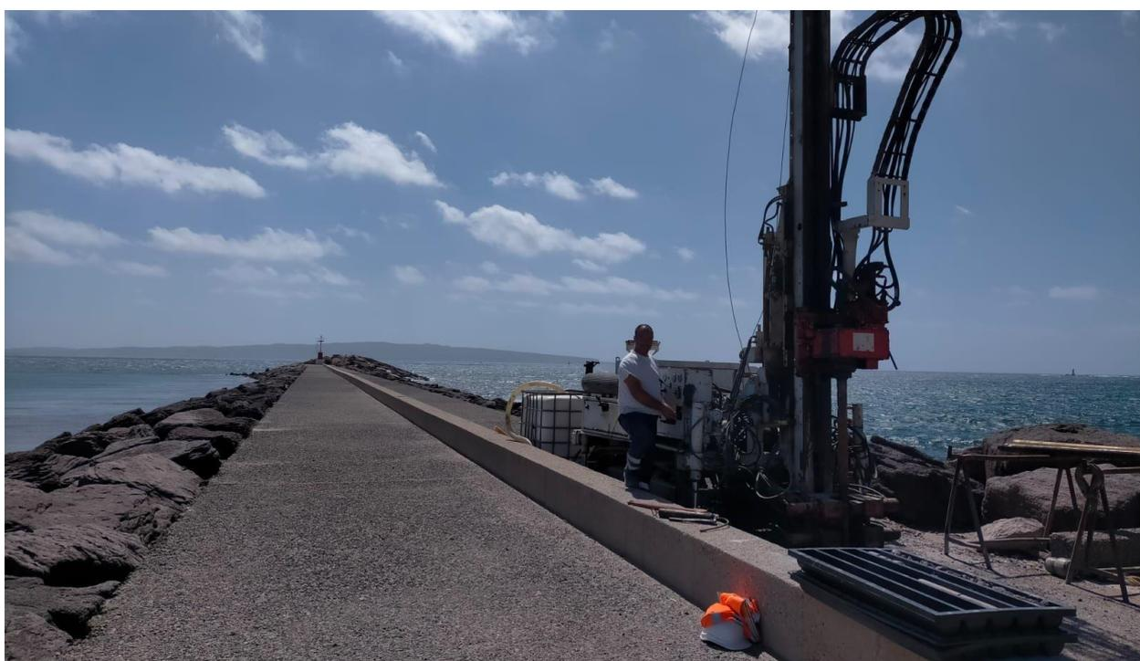
Figura 14. Esecuzione del Sondaggio 2 in corrispondenza del tratto iniziale della barriera frangiflutti
