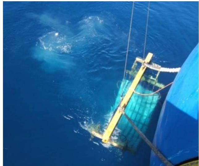
Figura 6.3 – Messa in posa di materasso mediante bilancino
