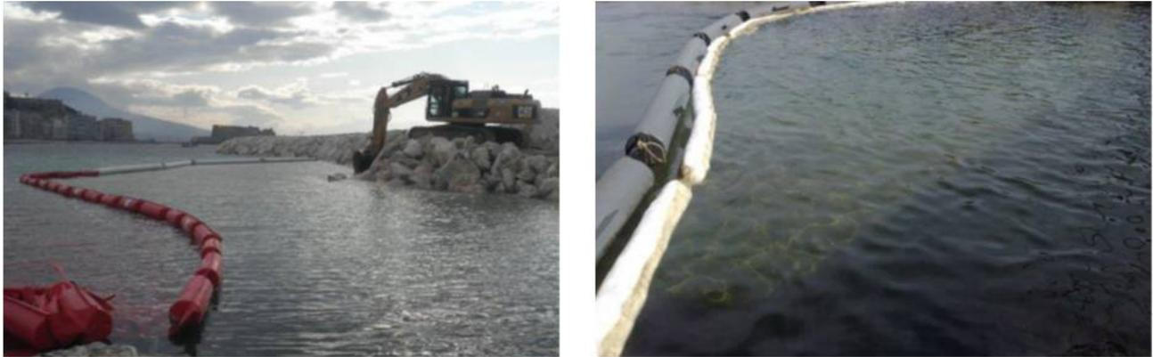
**Figura 6.15 – Misure anti-intorbidimento per il confinamento delle aree di lavoro a mare.**
