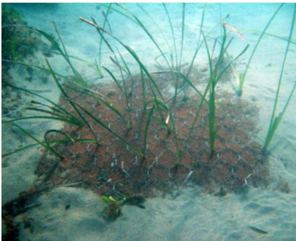
Tecnica di reimpianto mediante biostuoie in agave e geostuoie in polipropilene.
