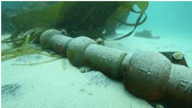
**Figura 6.7 – Esempio di posa con protezione in elementi modulari tubolari.**
