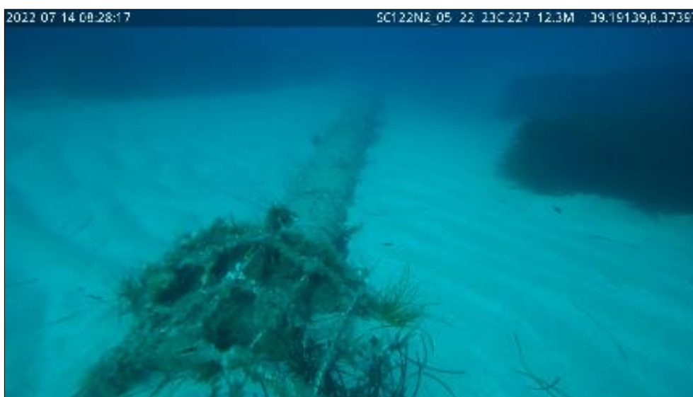
Figura 64. Tubazione metallica alla batimetrica dei 10/15 metri (da Nextgeo)
