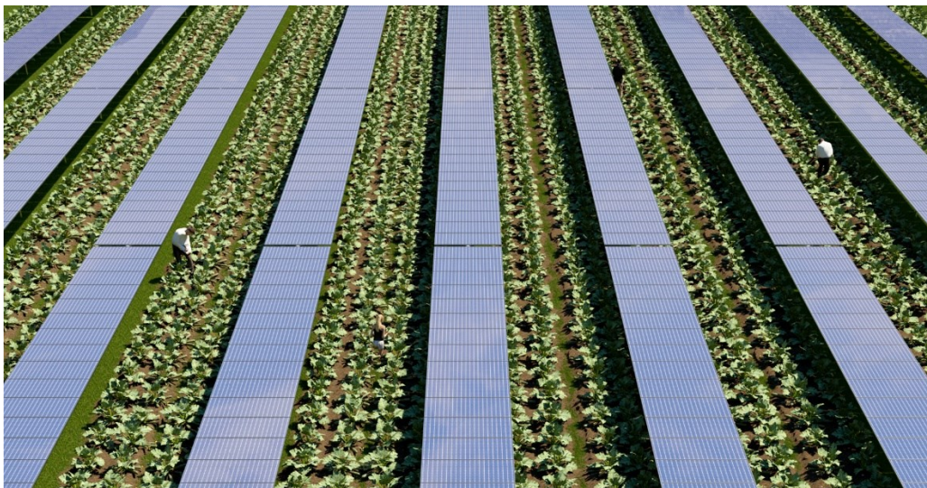
Figura 17 - Esempio di impianto agro-fotovoltaico
