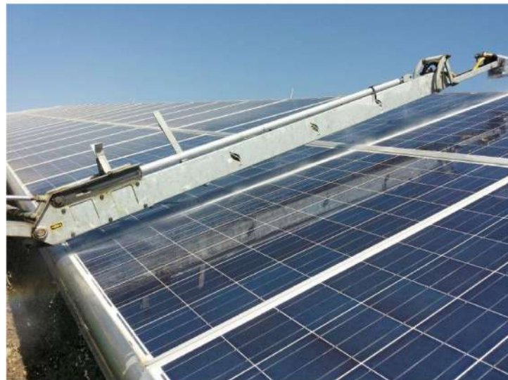
Figura 17 – Operazioni di pulizia moduli effettuate con sistema atomizzatore con uso esclusivo di acqua.
