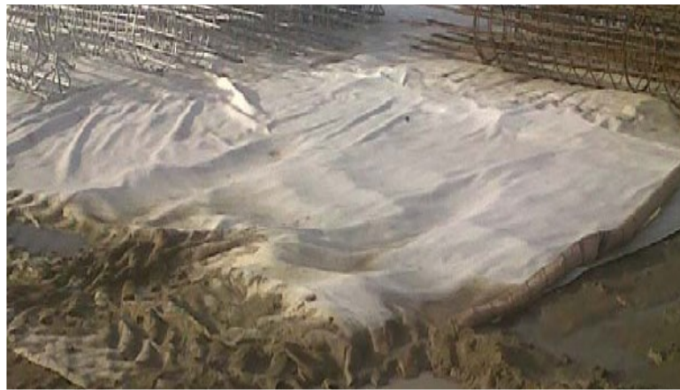
Figura 1 Posa di teli impermeabili nelle aree fisse di cantiere
