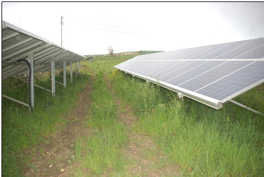
Figura 21 – Esempio impianto fotovoltaico con sistema fisso
