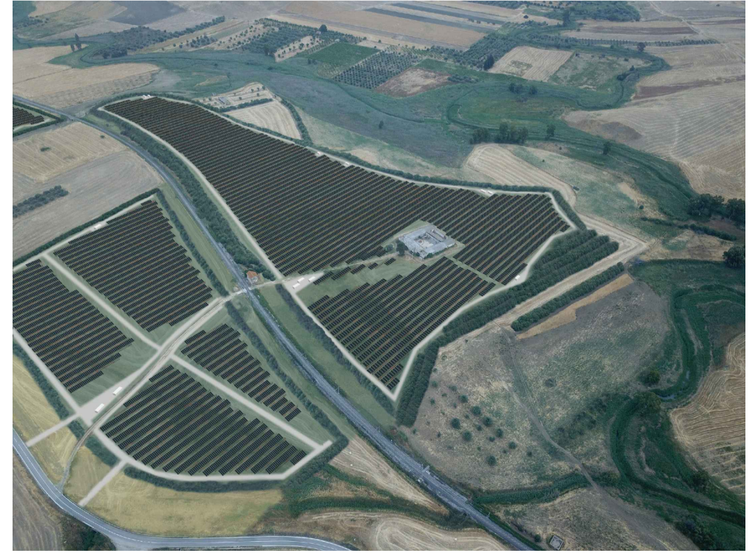
Punto di ripresa n°1 post operam senza cumulo con altri impianti.
