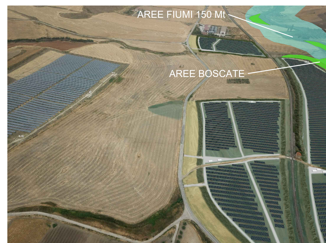
Punto di ripresa n°2 post operam.
