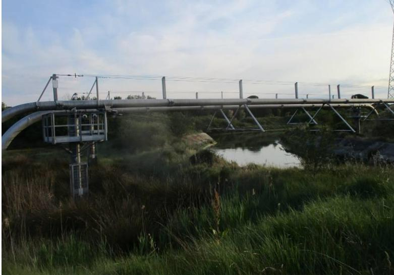
**Fig. 4.5/B – Metanodotto in rimozione, sopra un canale tributario del Canale Magni.**
