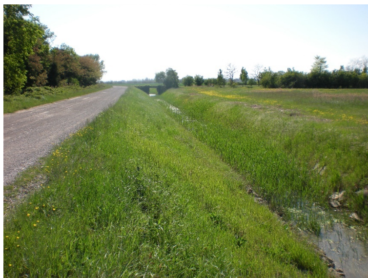
Fig. 2.2/B – Fossato presso l'area VEP02RA
