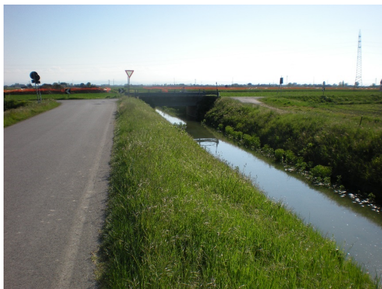
Fig. 2.3/B –Fossato presso l'area VEP03RA
