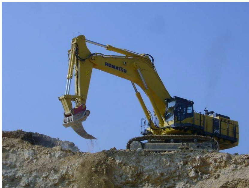
Ripper su escavatore
