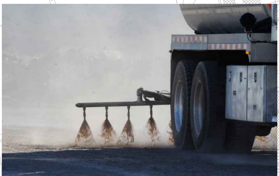
6 STABILIZZAZIONE CHIMICA DELLE PISTE DI CANTIERE
