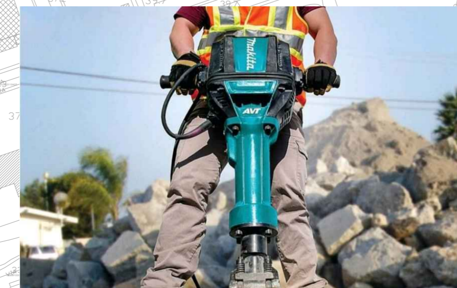
UTILIZZO DI DEMOLITORI ELETTRICI
