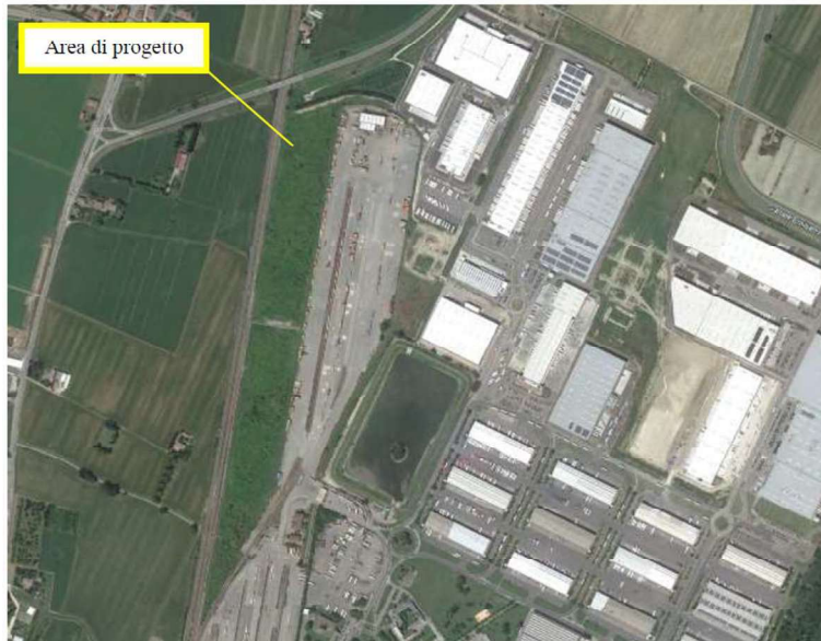
Ortofoto - stato di fatto
