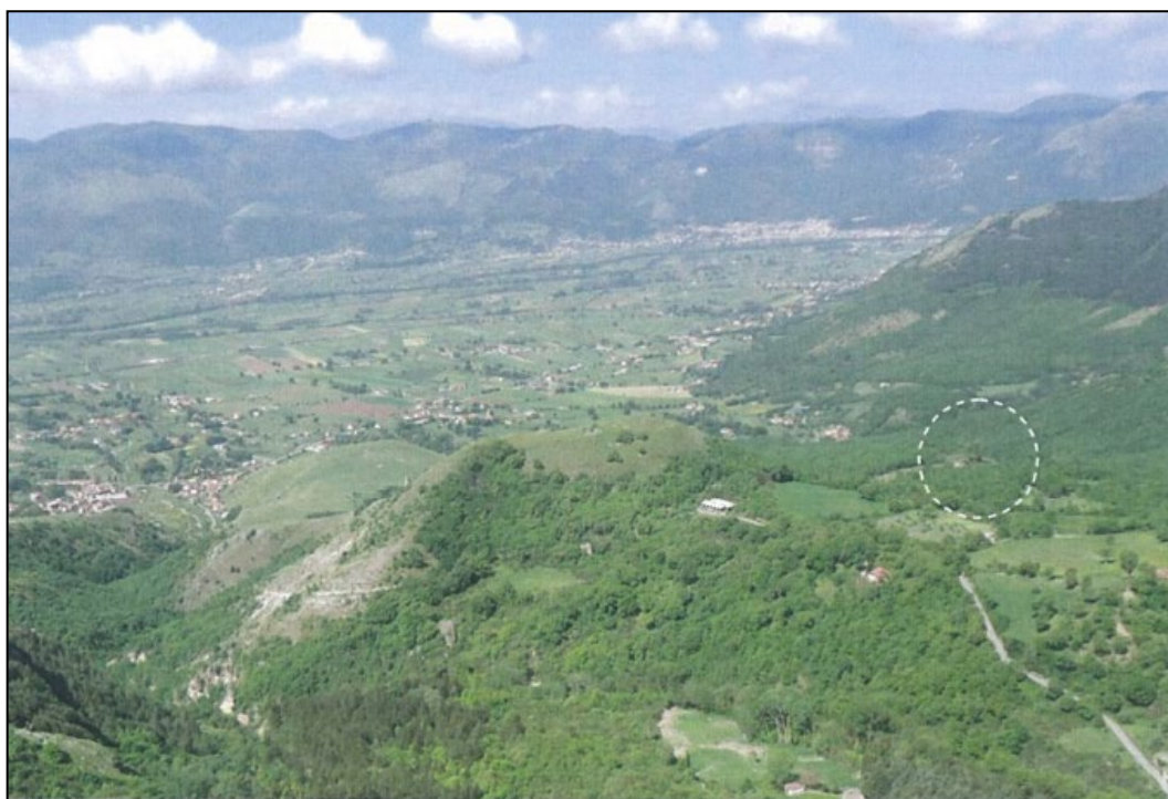
Figura 12.46: vista in fase di perforazione.
