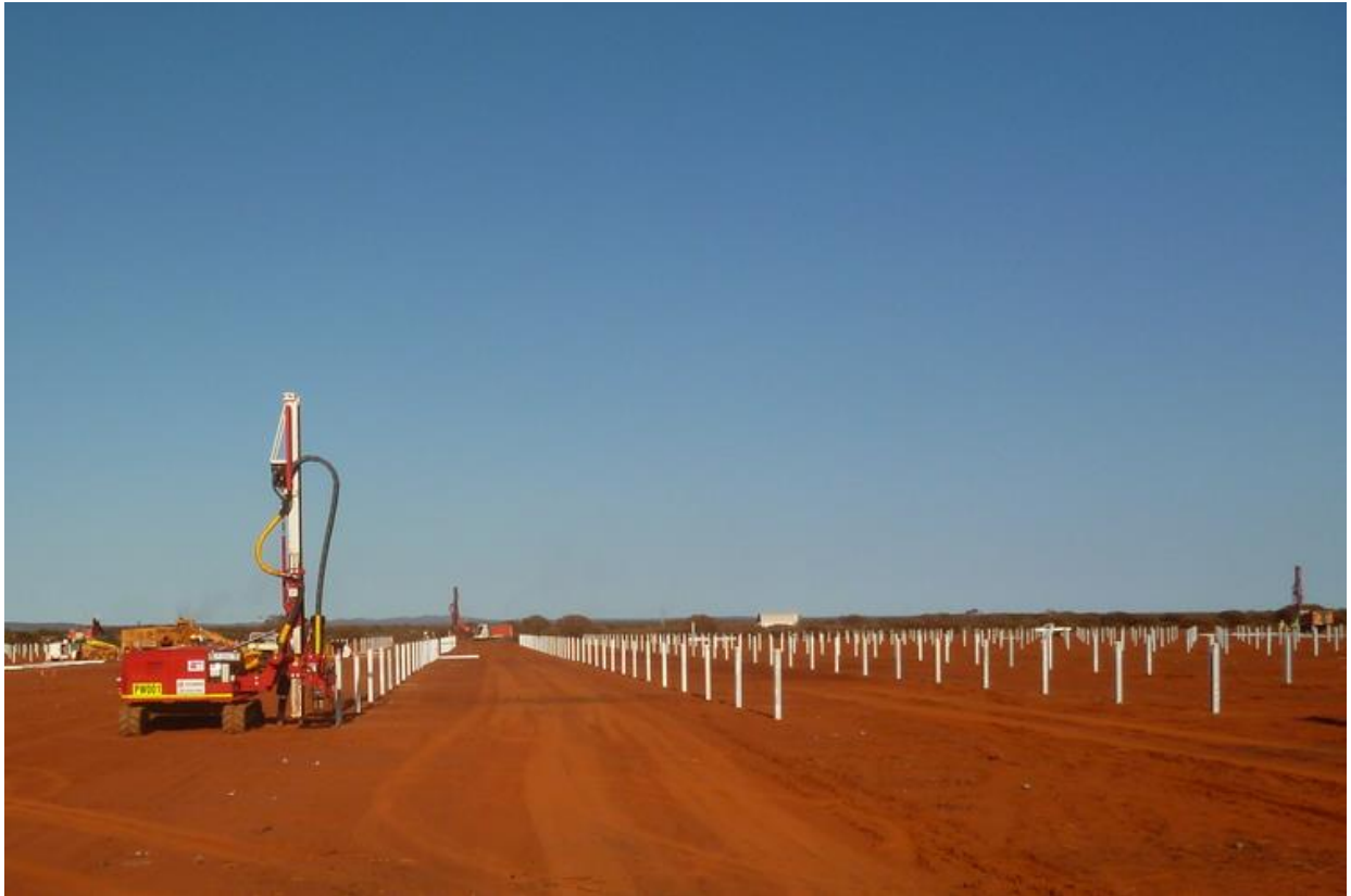
Figura 29: Dettaglio posizionamento pali
