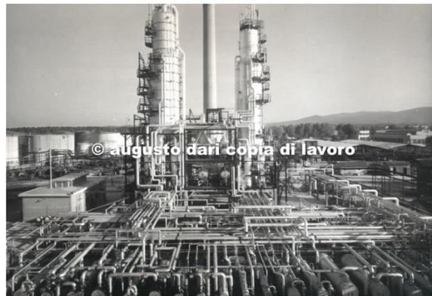
**Figura 1-** impianto di distillazione atmosferica e sottovuoto denominato Due Stadi con il fabbricato della relativa Sala Controllo
