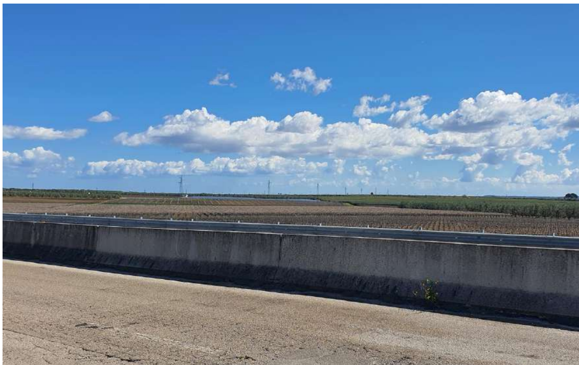
Stato di fatto – Punto di presa fotografica 15A
