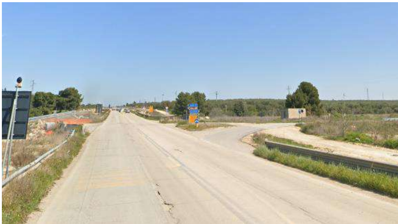
Figura 7- Tratto di cavidotto interessato dall'interferenza con il "Tratturello Via Traiana" coincidente con Strada Provinciale SP 231
