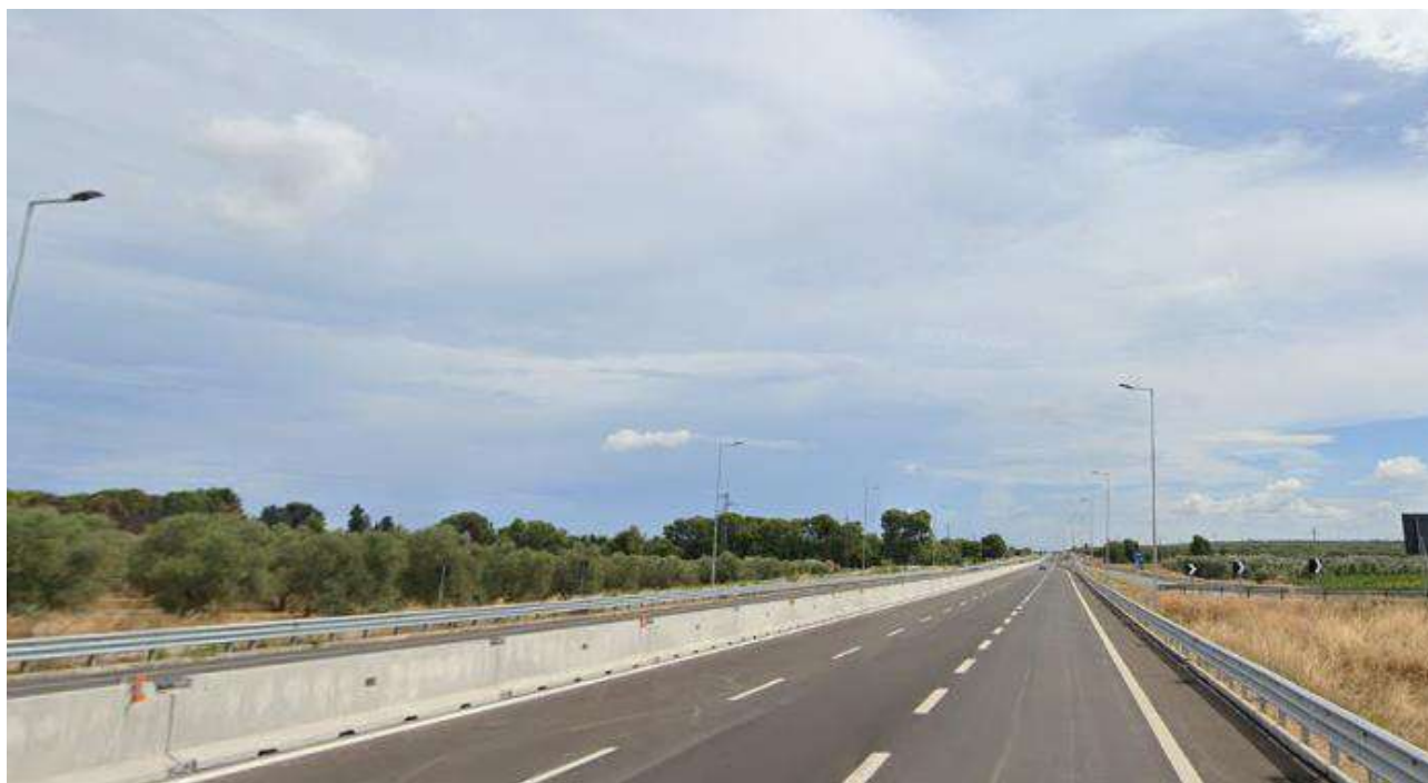
Figura 5 – Tratto di cavidotto interessato dall'interferenza con il "Tratturello Via Traiana" coincidente con Strada Provinciale SP 231
