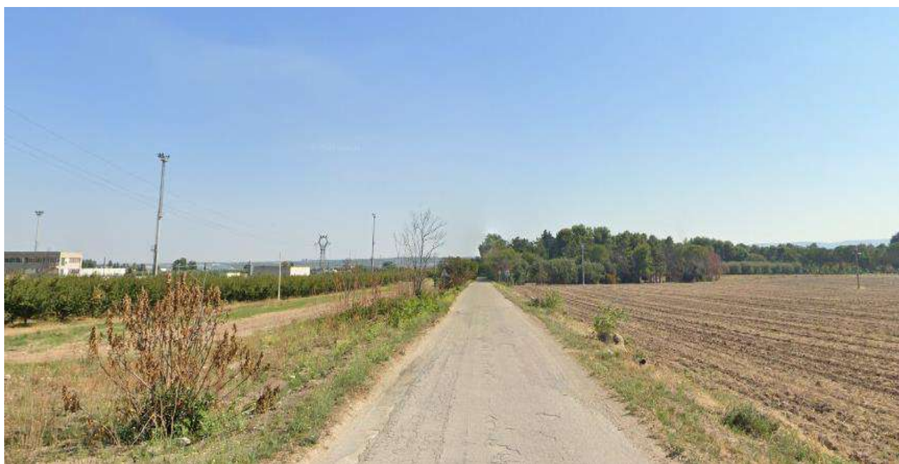
Figura 6 - Figura 5 – Tratto di cavidotto interessato dall'interferenza dall' interferenza con il "Tratturello Lavello Minervino" coincidente con Strada Provinciale SP 24
