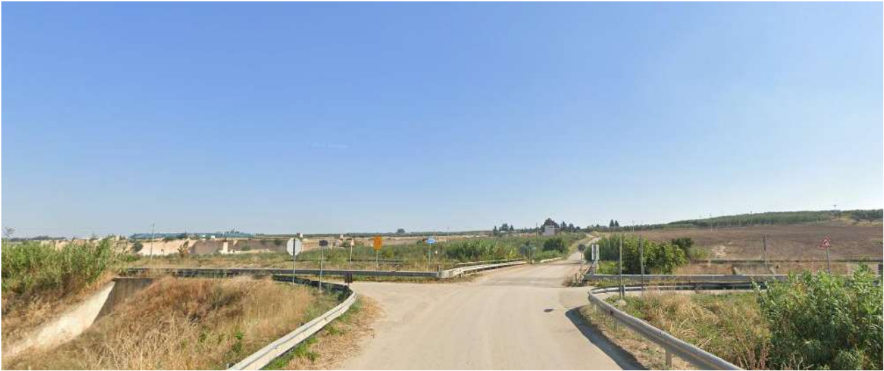
Figure 4 a/b – “Strada Provinciale 24” in corrispondenza dell’attraversamento “Torrente Locone”
