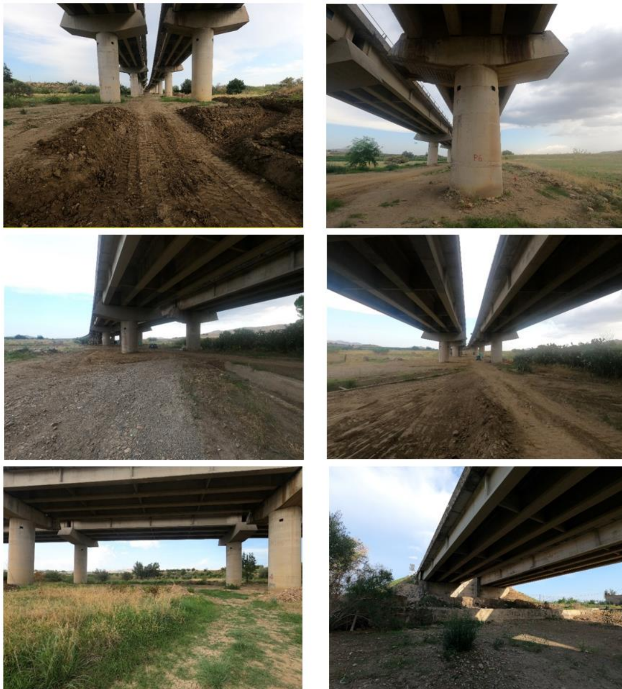
Figura 3: Vista degli elementi strutturali del viadotto Alfio
