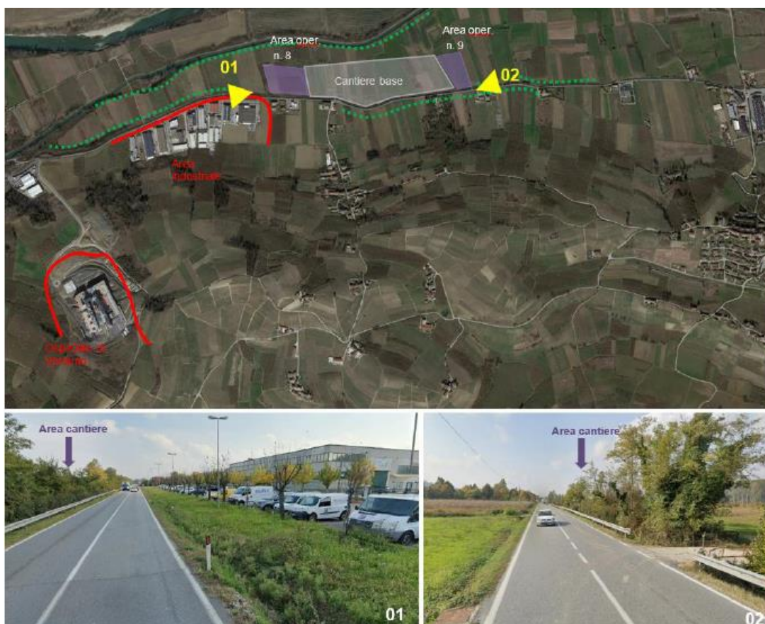
Figura 38 – Sequenza visiva lungo la Strada Provinciale 7
