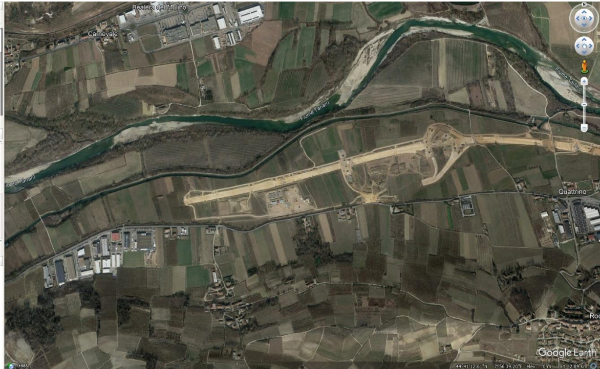
Figura 22 – Lotto 6B – cantiere base comune al Lotto 6B (foto Google marzo 2022)
