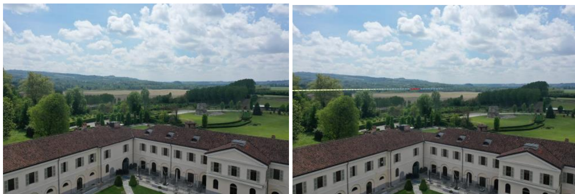
Figura 42 – Vista Sud Est collegamento al viadotto autostradale esistente
