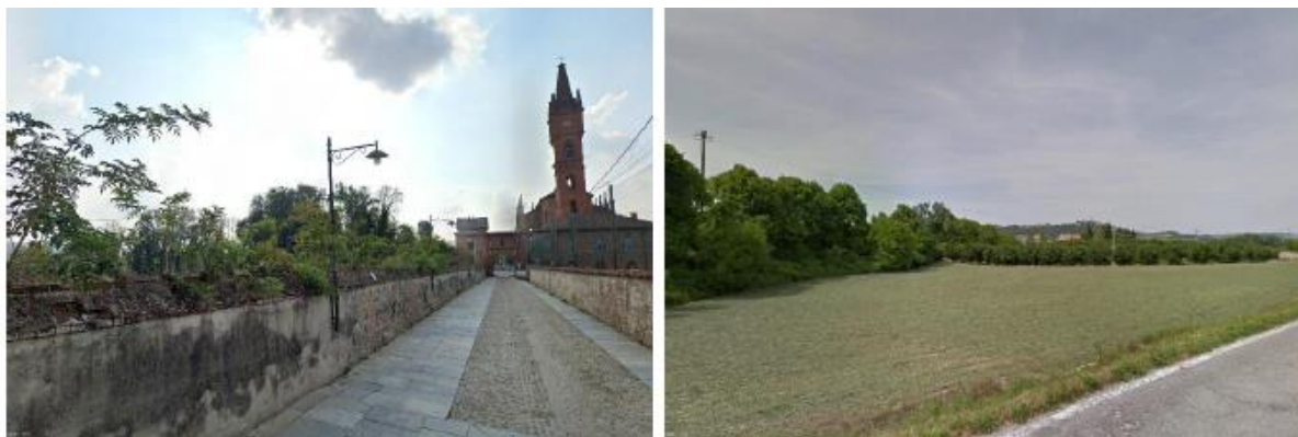
Figura 41 – Condizioni di visibilità dell'opera da punti di vista radenti
