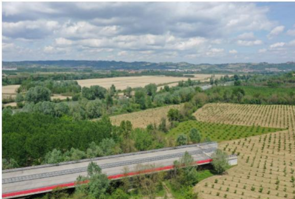
Figura 4 – Foto della condizione del contesto del punto di attacco del Lotto 6.II.a in assenza del progetto dell’infrastruttura.
