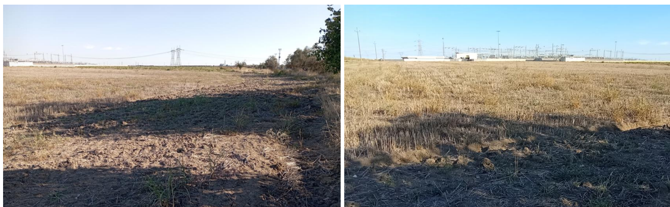
Figura 2-24: Scatti fotografici del suolo interessato dalla Stazione Elettrica Utente e dalle opere di connessione
