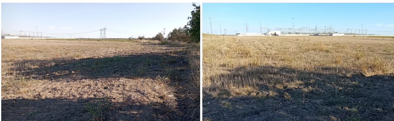
Figura 4-3: Scatti fotografici del suolo interessato dalla Stazione Elettrica Utente e dalle opere di connessione
