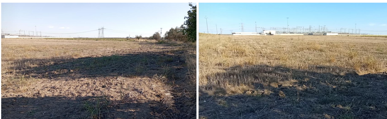
Figura 4-5: Scatti fotografici del suolo interessato dalla Stazione Elettrica Utente e dalle opere di connessione
