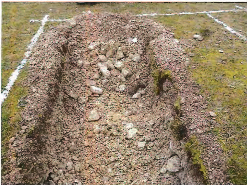
Scavo sullo strato con riporto antropico di ghiaia
