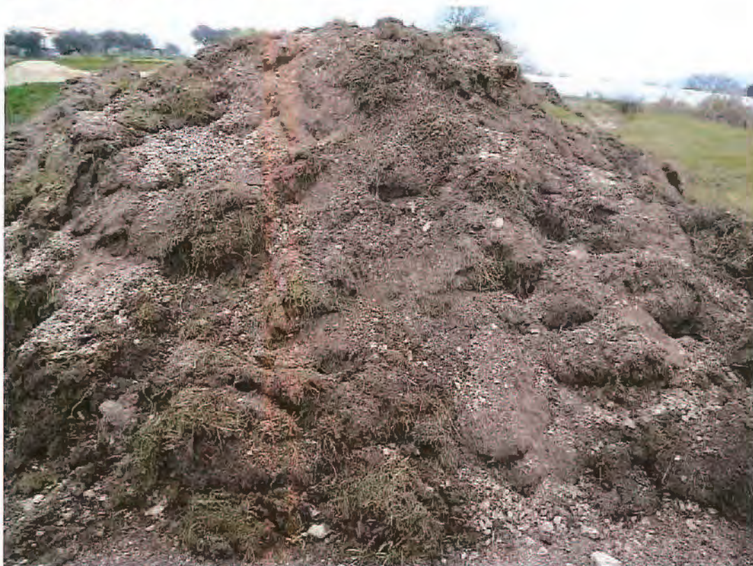
Terra accumulata ai lati dell'area a seguito della decorticazione
