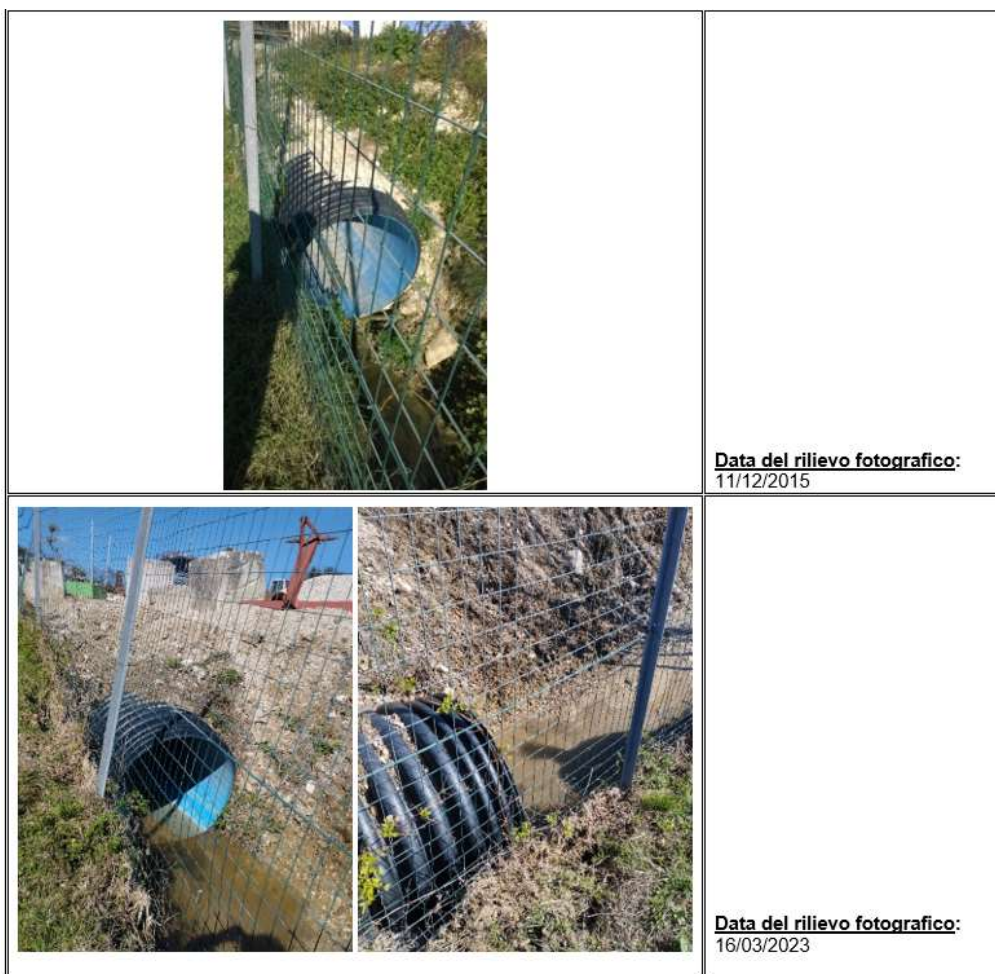
Figura 17: confronto fotografico relativo al collettore artificiale del deflusso idrico superficiale posto a Nordest dell'area pozzo
