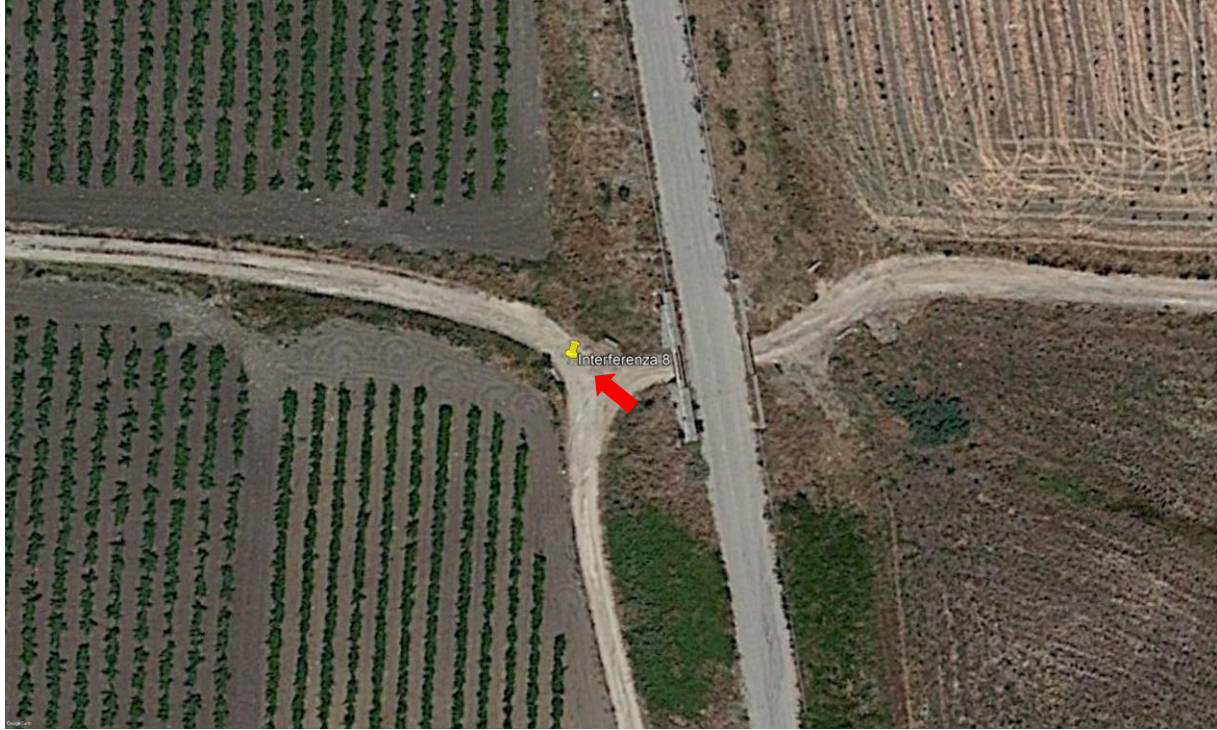
Figura 19. Ortofoto attraversamento con scatolare in cls
