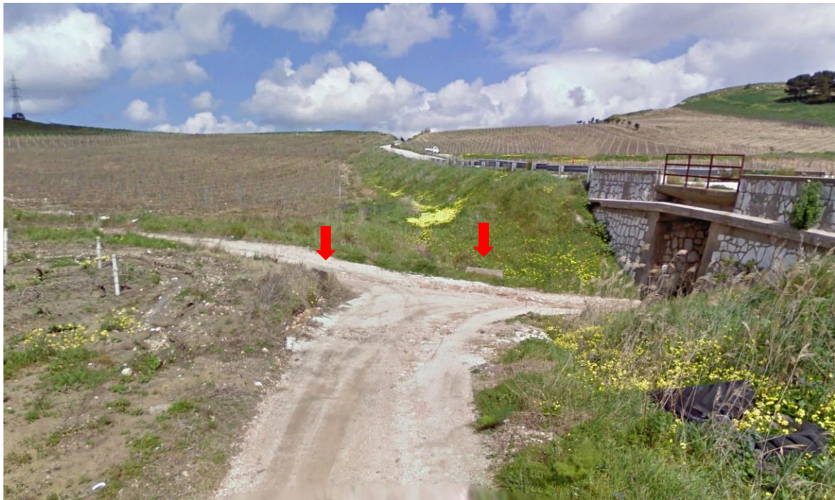
Figura 20. Vista attraversamento con scatolare in cls
