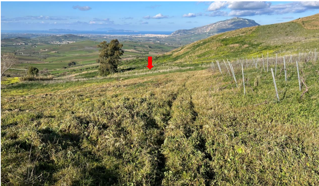
Figura 18. Vista attraversamento di reticolo idrografico
