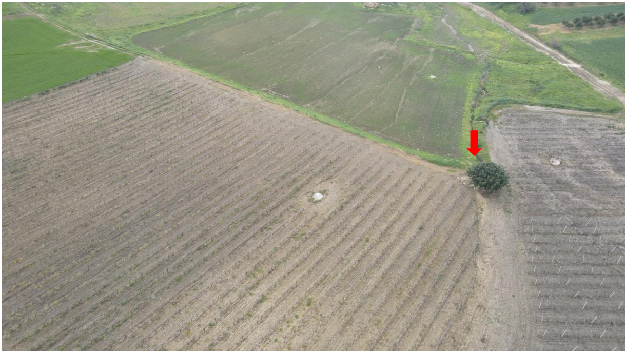
Figura 10. Vista attraversamento con scatolare in cls su reticolo idrografico
