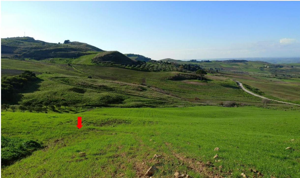
Figura 14. Vista attraversamento di reticolo idrografico
