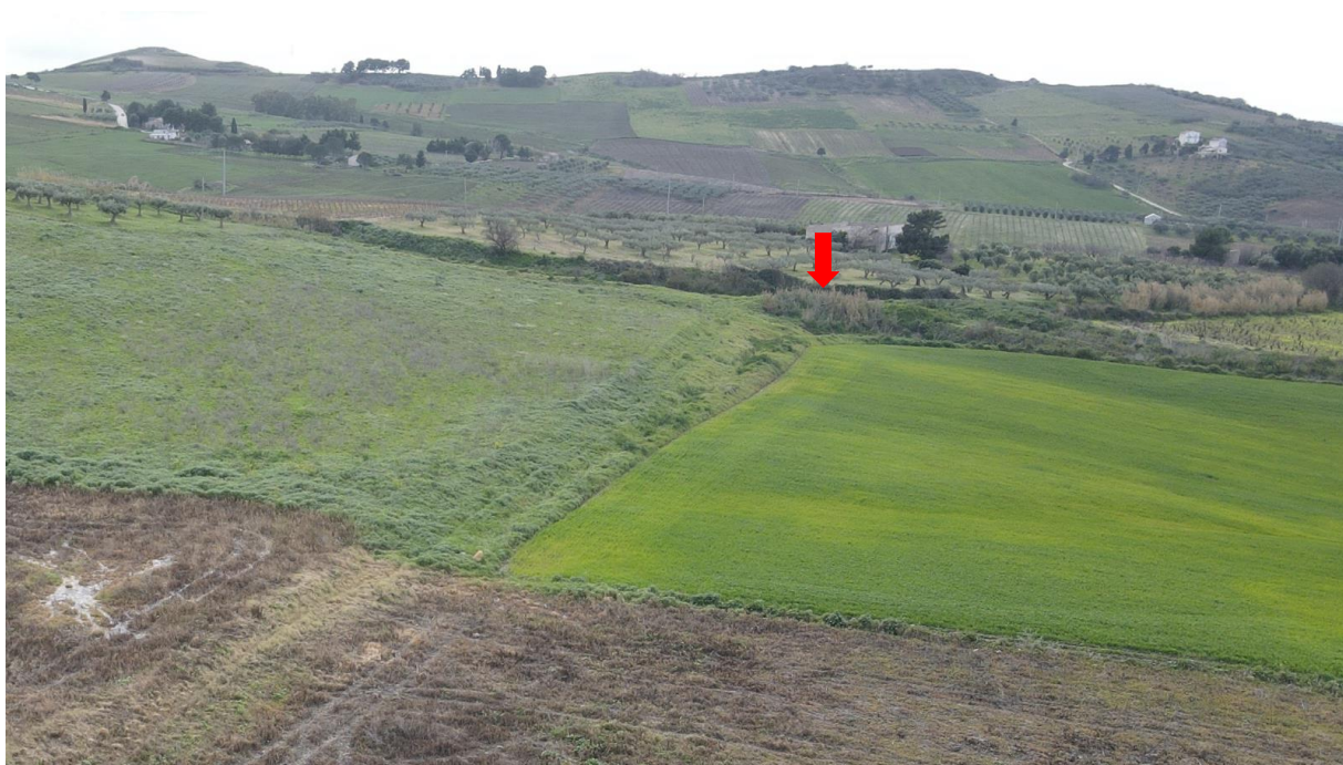
Figura 6. Vista attraversamento con scatolare in cls.
