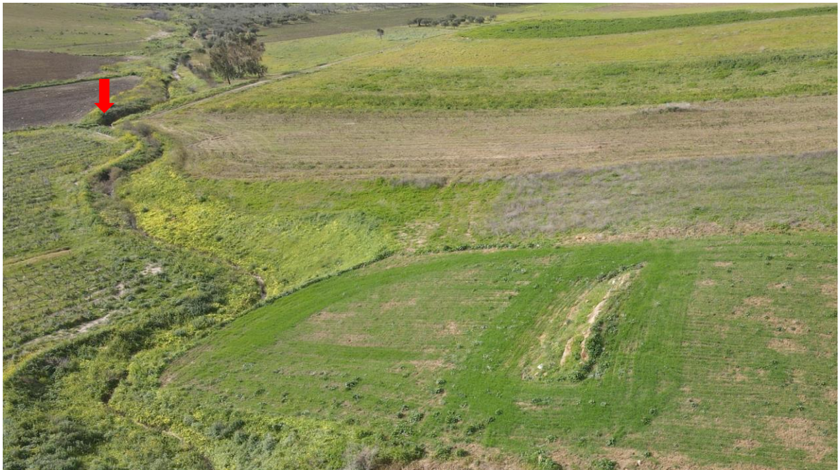
Figura 8. Vista attraversamento corso d'acqua
