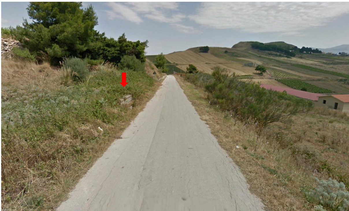
Figura 22. Vista attraversamento con scatolare in cls
