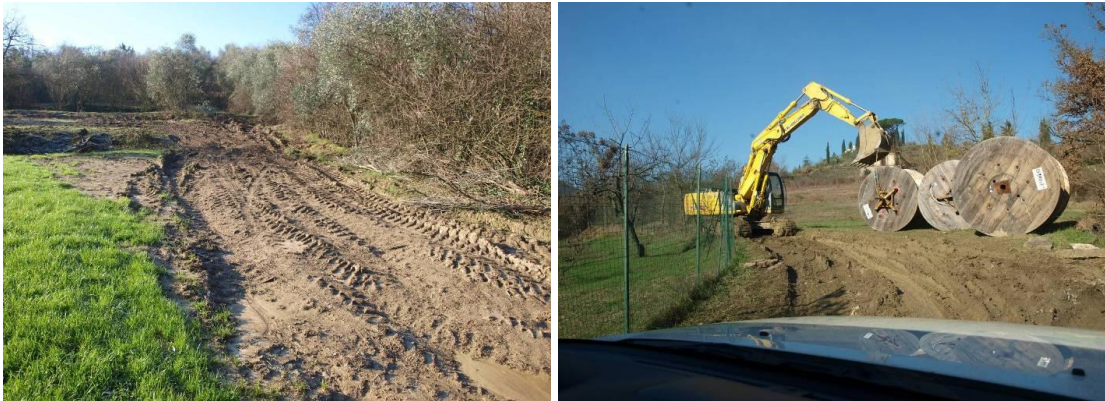
Figura V.10 - pista di accesso ai minicantieri dei nuovi tralicci (sx) e trasporto dei conduttori tramite piste temporanee (dx)
