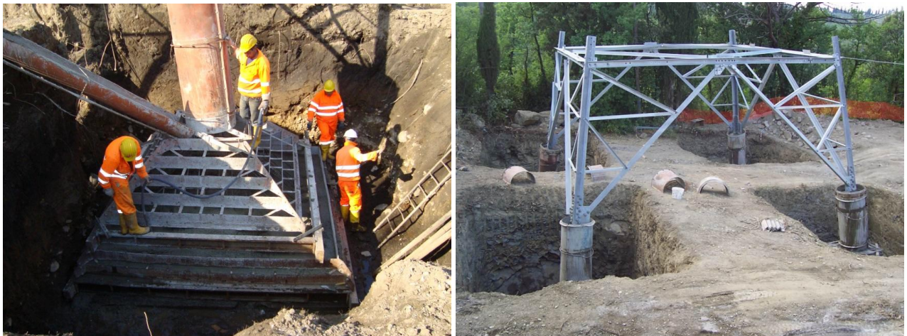
Figura V.1 - Esempio di fondazione di un sostegno
