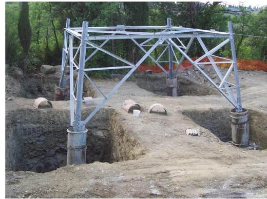
**Figura I.3 - Esempio di fondazione di un sostegno**
