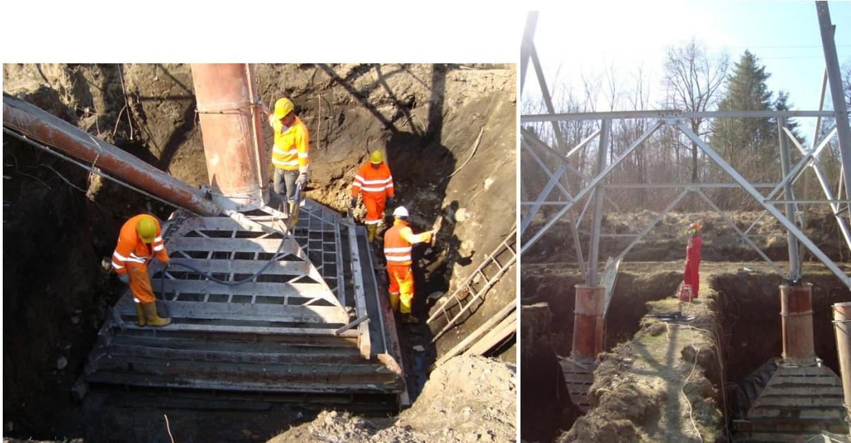
**Figura VI.2 - Esempio di realizzazione del piede di fondazione**
