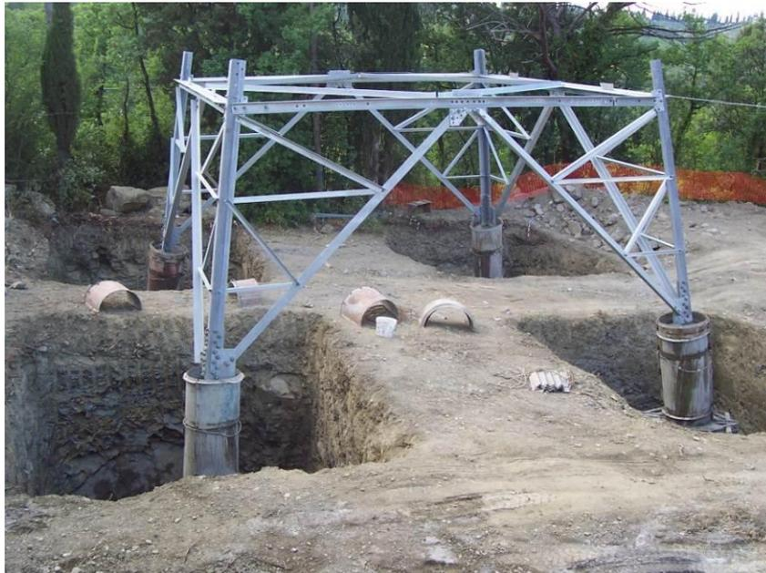
**Figura VI.1 - Esempio di fondazione di un sostegno**
