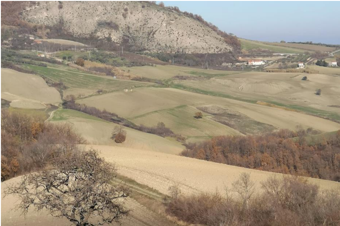
Foto 3: Versante affetto da più tipi di movimenti gravitativi, sia di tipo areale (creep), sia localizzato (si nota uno scorrimento e altri fenomeni complessi meno visibili). In alto è visibile un contatto morfoselettivo fra i blandi pendii inferiori prevalentemente argillosi e la formazione arenacea della parte superiore.
