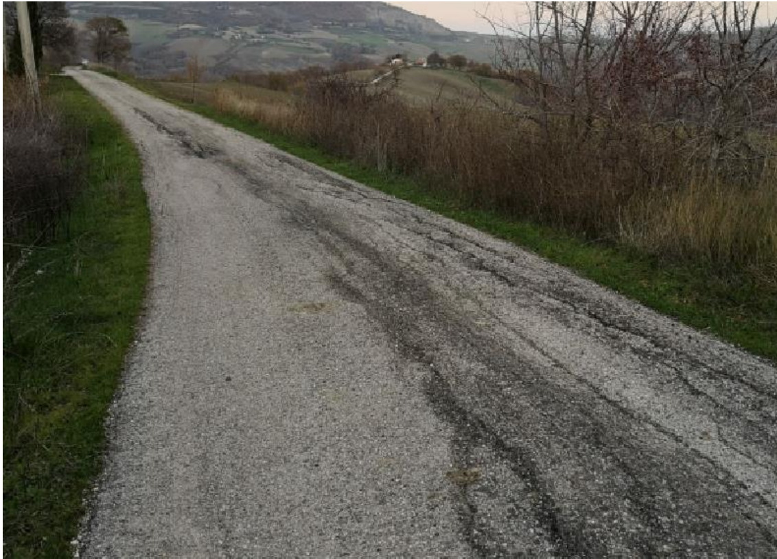
Foto 2: Deformazioni nella zona della corona di distacco di un fenomeno complesso.
