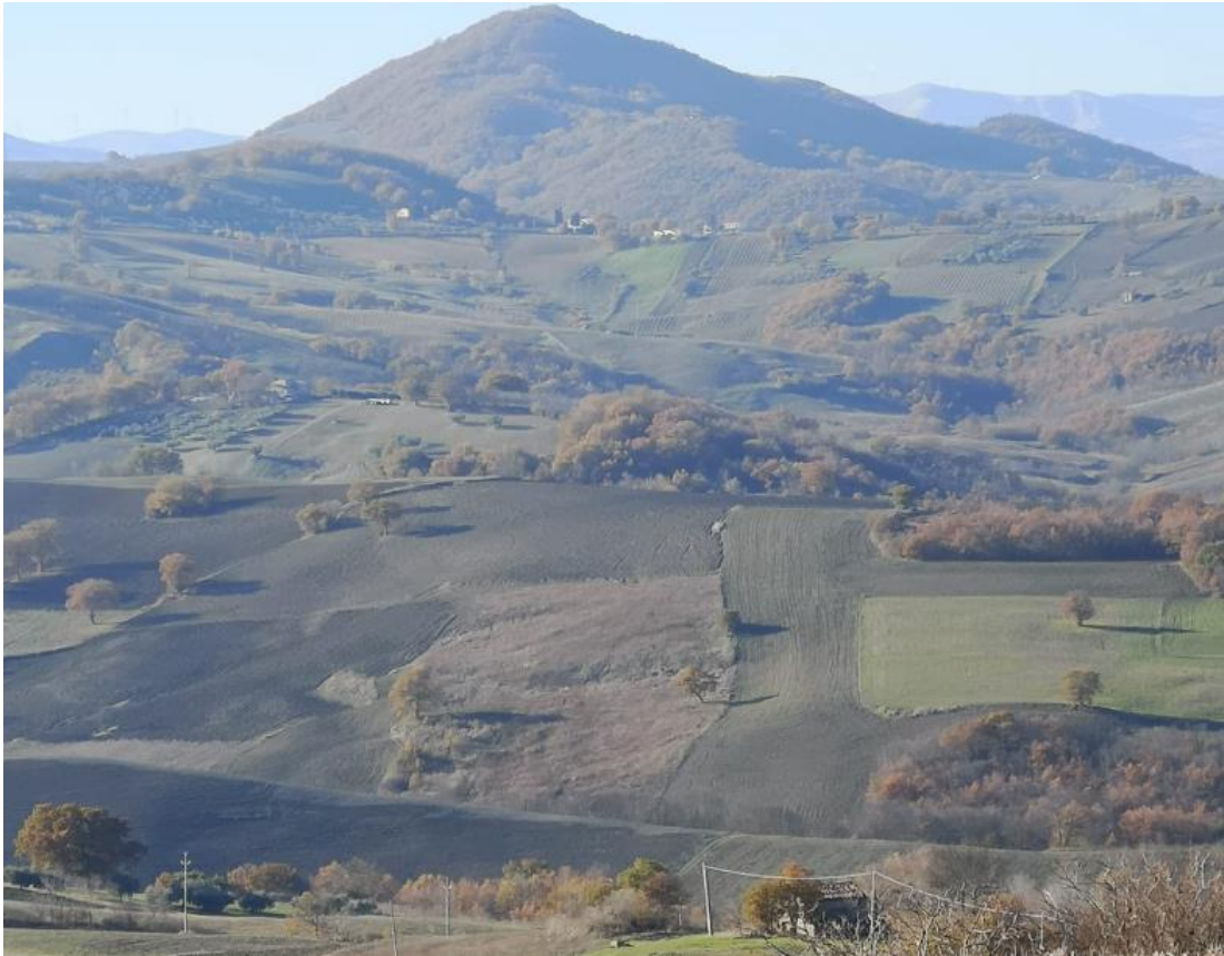
Foto 4: Movimento franoso attivo e deformazioni diffuse sul versante.
