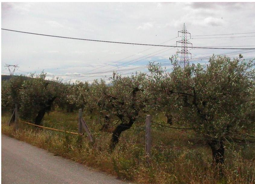
**Figura II.10 - Tratto delle linee elettriche "Montecorvino – S. Sofia" in singola terna a 380 kV e "Montecorvino – Salerno Nord" in doppia terna a 220 kV.**
