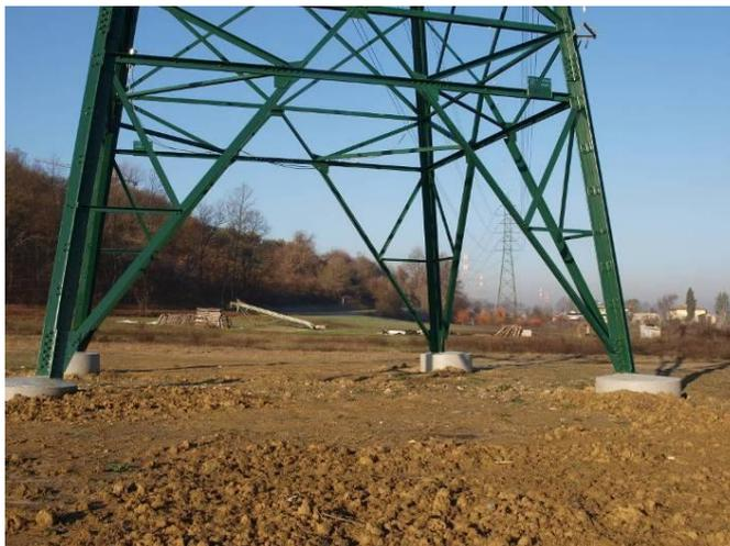
**Figura VII.1 – Ricostituzione suolo agrario sulla superficie dismessa di un microcantiere**
