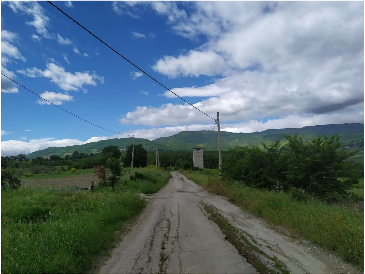
Figura 33. Attraversamento di linea elettrica BT e MT lungo il tracciato da adeguare per di collegamento con le WTG (477998.53 m E, 4635655.40 m N)
