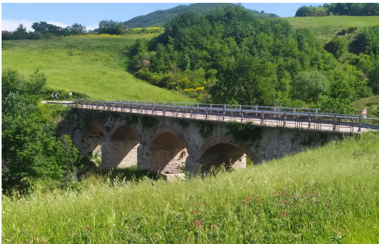
Figura 42. Opera di attraversamento in corrispondenza della viabilità esistente per il collegamento con la WTG 01 (475663.97 m E, 4634568.01 m N)
