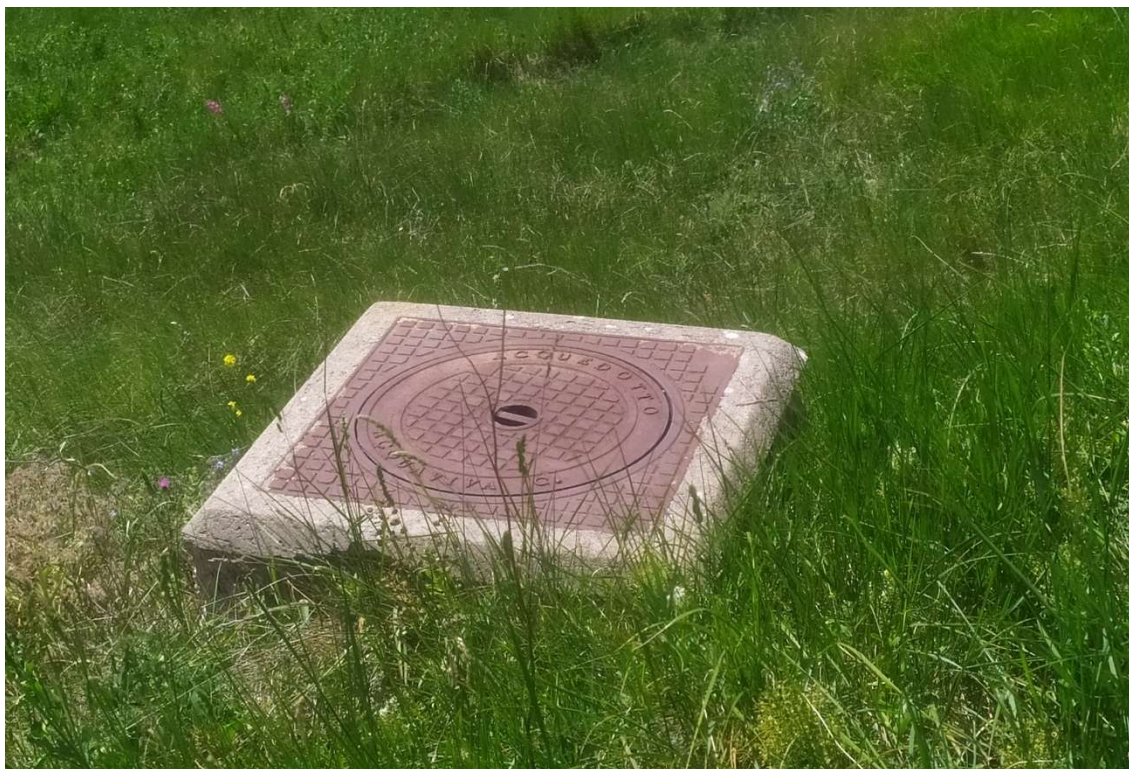
Figura 7. Tombino appartenente all'acquedotto di Acquaviva in corrispondenza della viabilità di collegamento con la WTG 2 e con la WTG 3.
