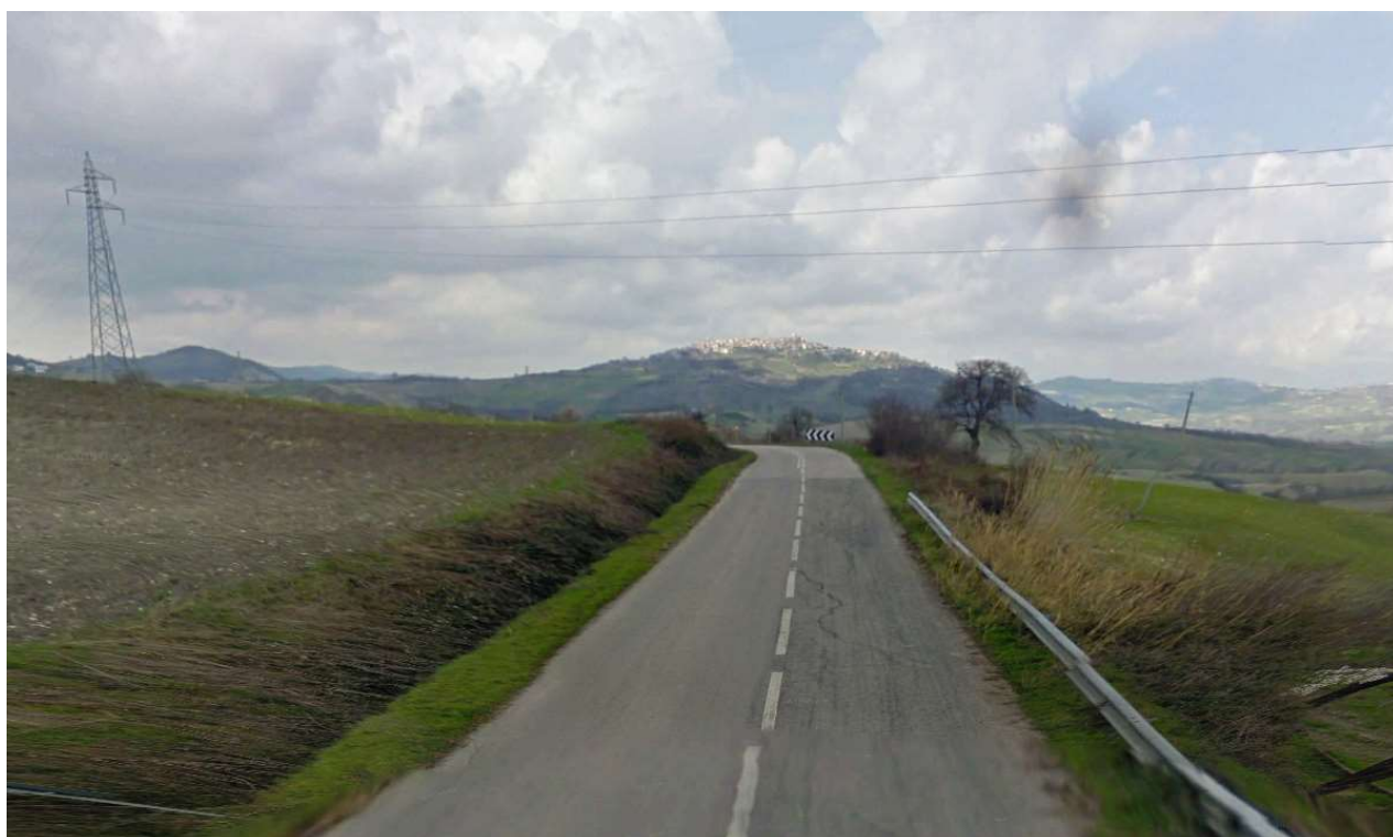
Figura 29. Interferenza della linea elettrica aerea e la viabilità esistente di collegamento (476708.35 mE, 4634288.06 mN)
