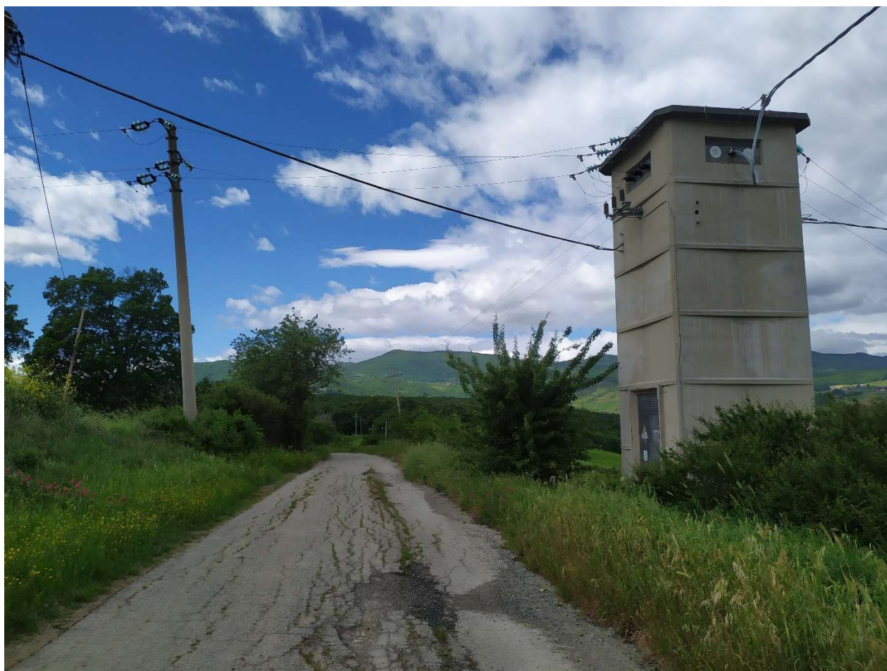
Figura 32. Attraversamento di linea elettrica BT e MT lungo il tracciato da adeguare per il collegamento con le WTG (477934.57 m E, 4635558.95 m N) lato nord.
