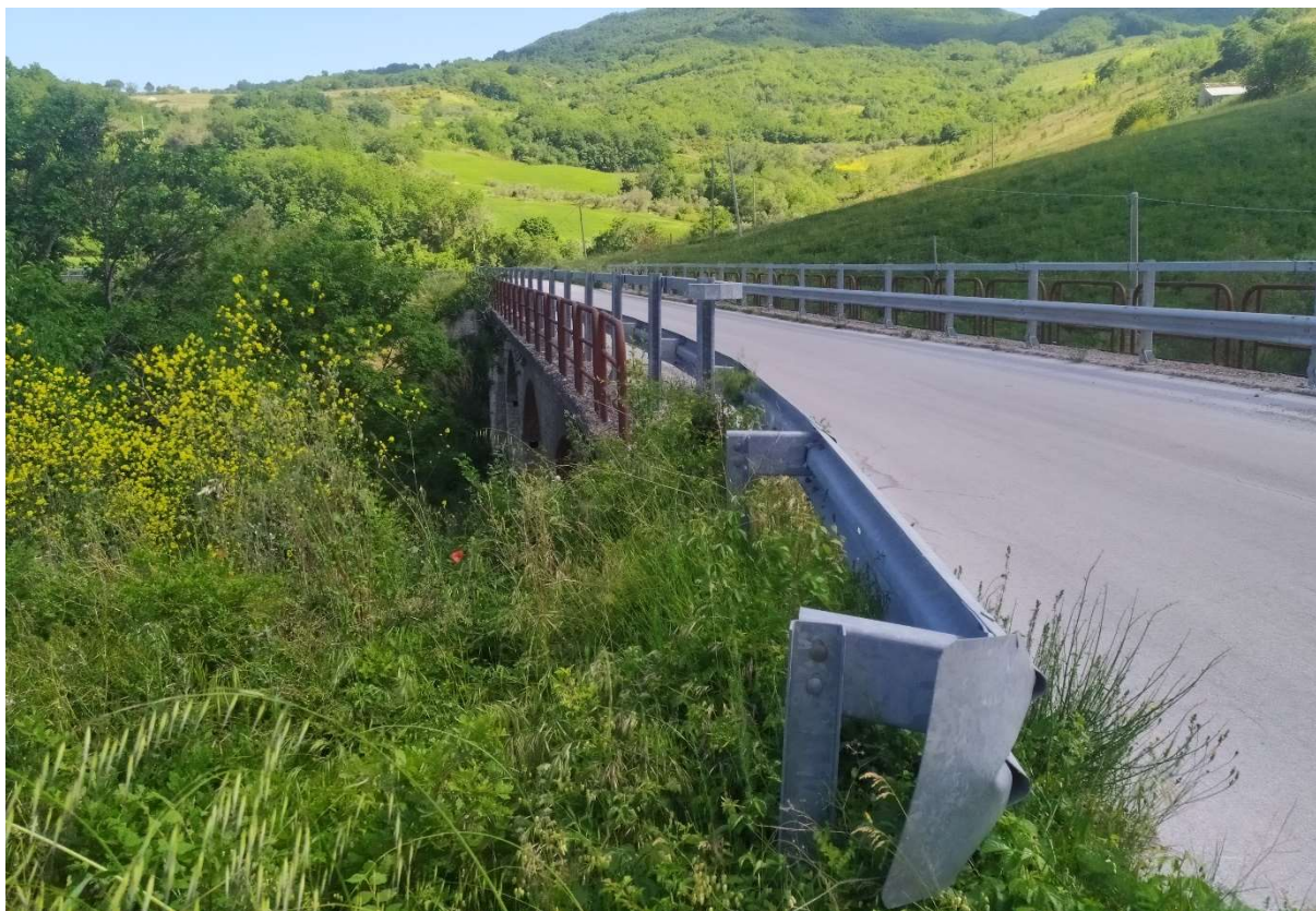
Figura 43. Opera di attraversamento in corrispondenza della viabilità esistente per il collegamento con la WTG 1 (476033.70 m E, 4634205.71 m N)
