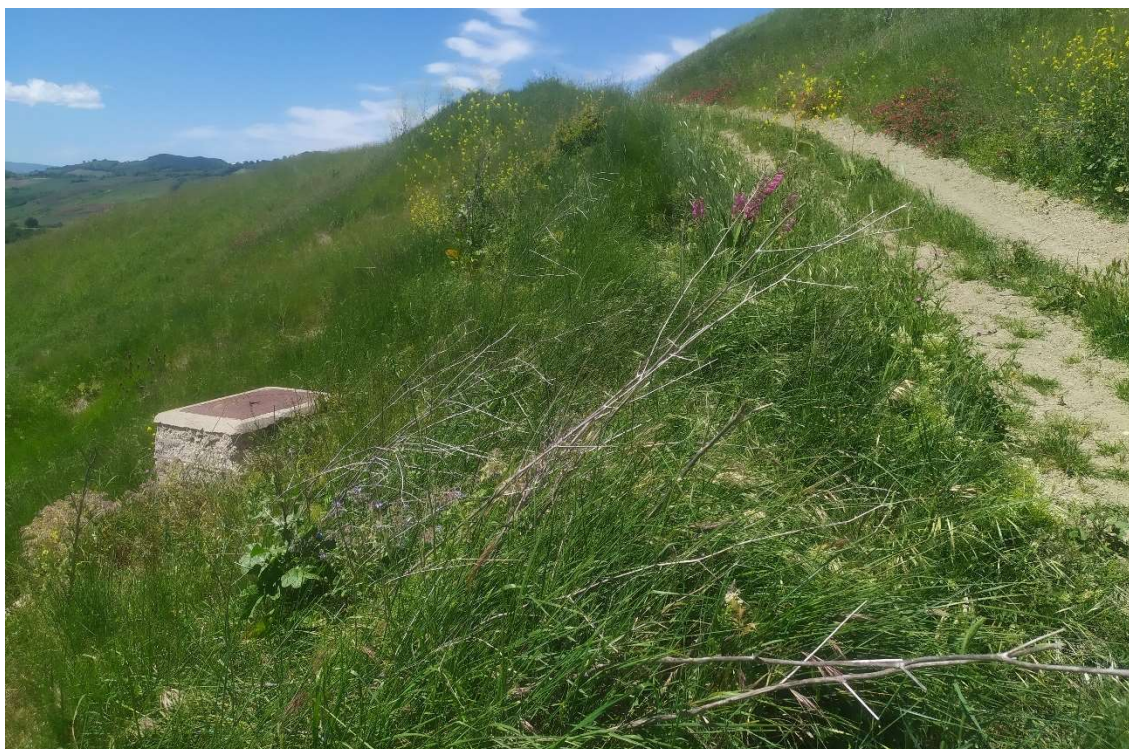
Figura 8. Tombino appartenente all'acquedotto di Acquaviva in corrispondenza della viabilità di collegamento con la WTG 2 e con la WTG 3.
