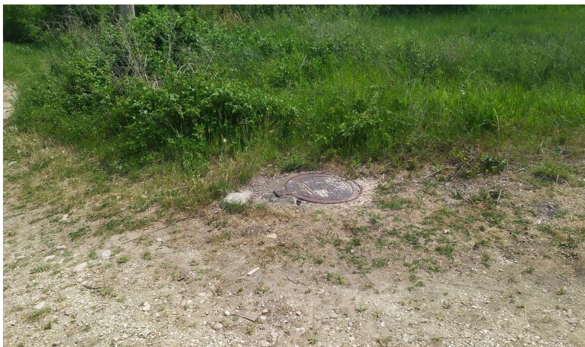
Figura 19. Pozzetto rilevato in corrispondenza del punto di coordinate (483324.25 m E 4640193.96 m N).
