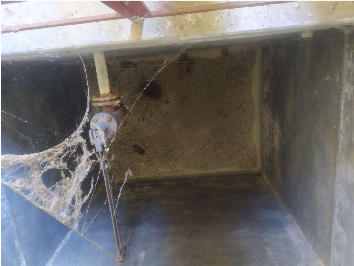
Figura 11. Interno della probabile camera di manovra dismessa
