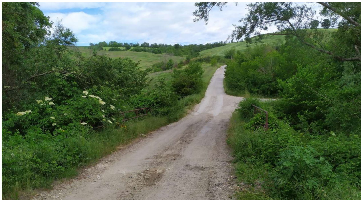
Figura 47. Opera di attraversamento in corrispondenza della viabilità esistente sulla strada comunale "macchialonga" per il collegamento delle WTG 6 e WTG 7 (478981.29 m E, 4635839.15 m N)
