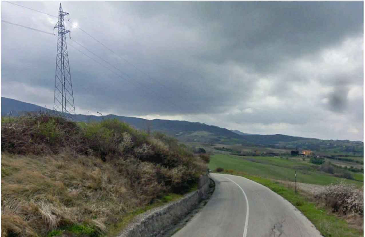
Figura 30. Interferenza della linea elettrica aerea e la viabilità stradale esistente di collegamento (477282.35 mE, 4634091.12 mN)
