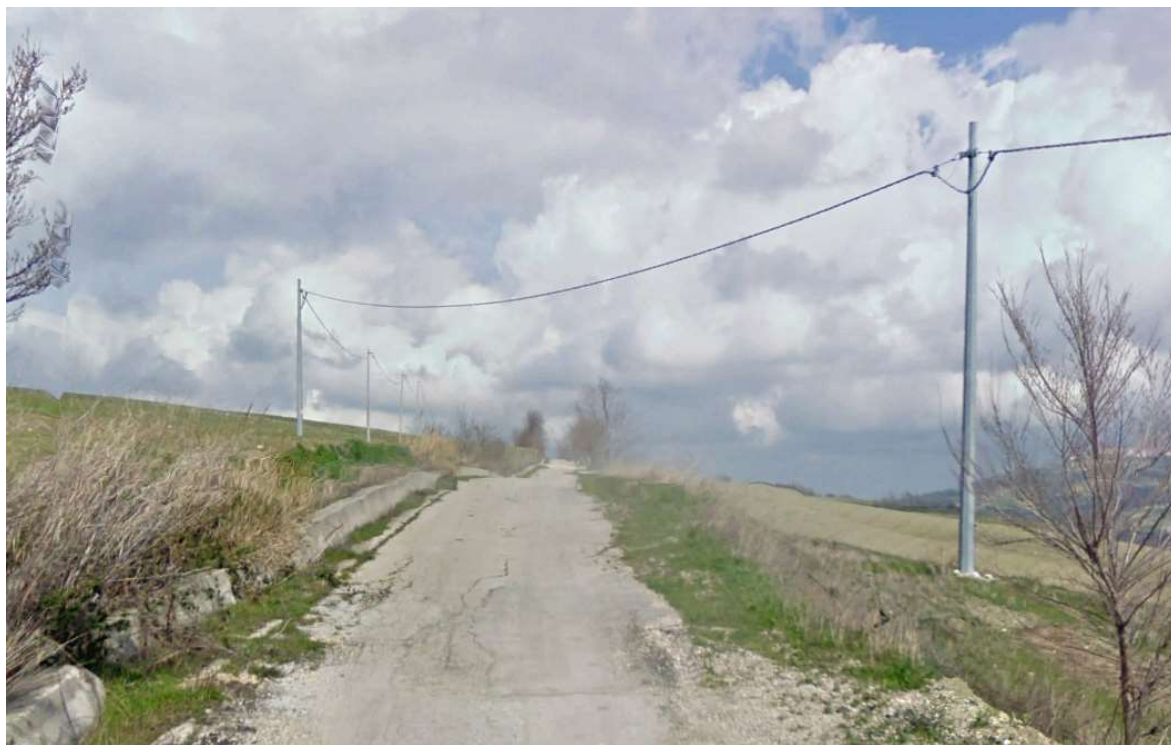
Figura 36. Attraversamento di linea elettrica lungo il tracciato di collegamento con le WTG (478350.28 m E, 4636046.95 m N)
