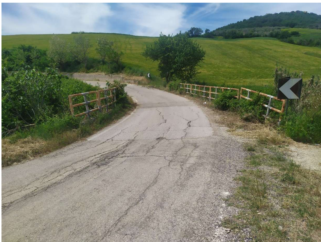
Figura 51. Opera di attraversamento in corrispondenza della viabilità esistente sulla strada provinciale Frentana per la connessione alla stazione multiutente 150/33 kV (481864.04 m E, 4639487.62 m N)
