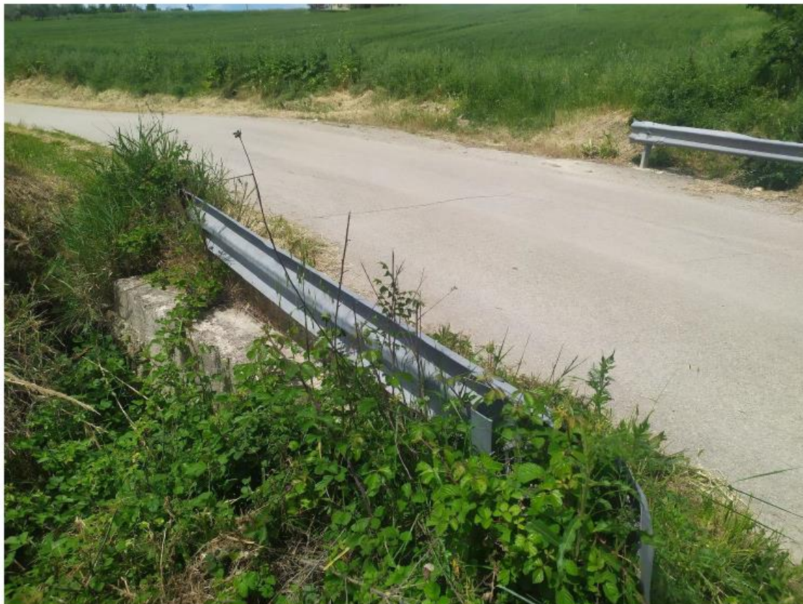
Figura 38- Vista dal punto P26: stato dei luoghi dove verrà posato il cavidotto in MT. Il cavidotto si svilupperà lungo la strada esistente SP13
