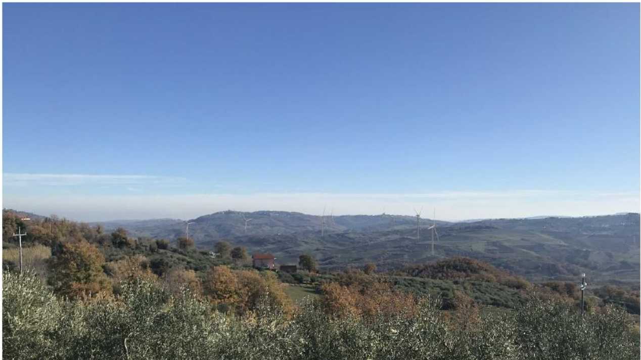
Foto 13 - Post-operam: inquadramento dell'impianto dal punto di ripresa P2 (Coordinate: 475136.71 m E; 4638232.34 m N – Angolo: 99° N)
