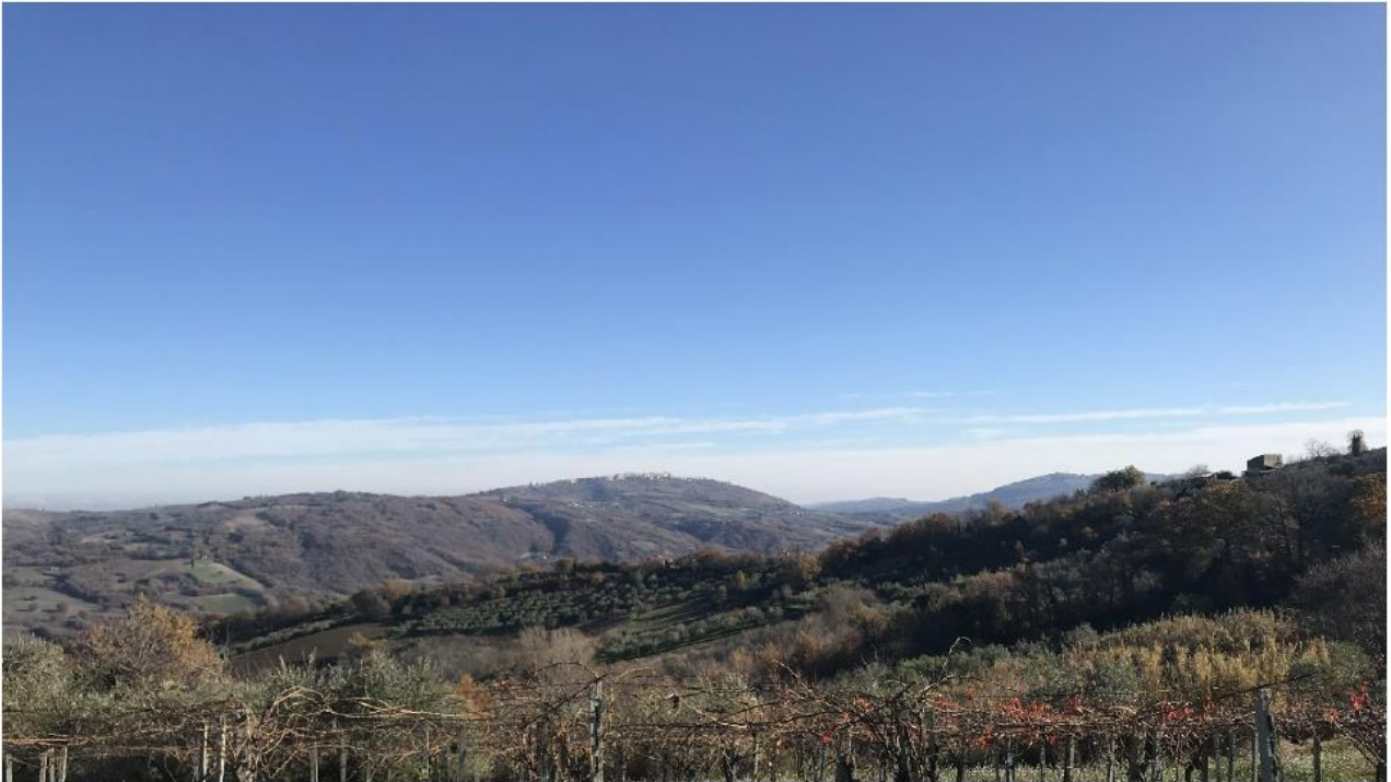
Foto 14 - Ante-operam: inquadramento dell'impianto dal Punto di ripresa P3 (Coordinate: 475111.833 m E; 4638229.976 m N – Angolo: 77° N)
