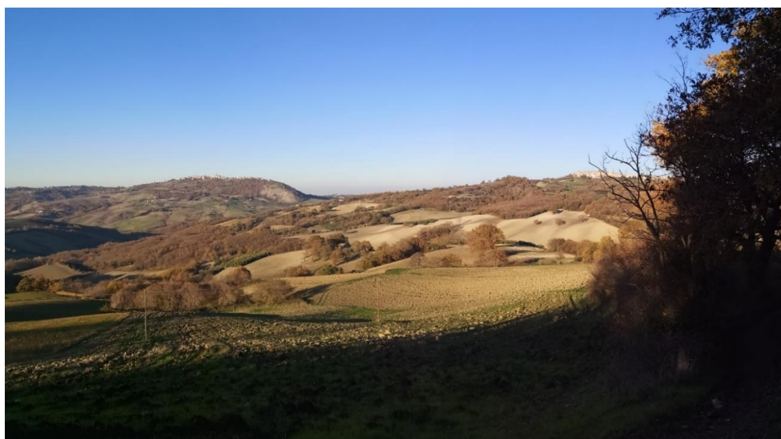
Foto 7 – Vista del posizionamento della WTG7
