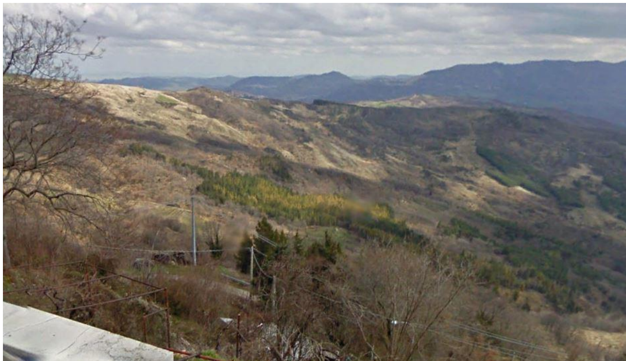
Foto 53 - Ante-operam: Inquadramento dell'area di posizionamento delle WTG (Visuale da Punto di ripresa P23 – Coordinate: 461295.05 m E; 4633584.04 m N – Angolo: 75° N. Fonte: Google Street View)
