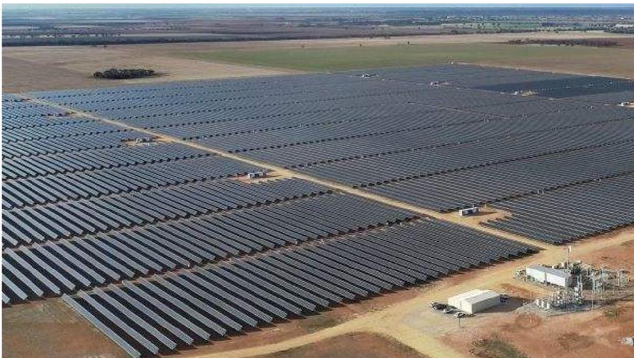
Figura 3.13: Esempio di impianto fotovoltaico installato su tracker monoassiali
