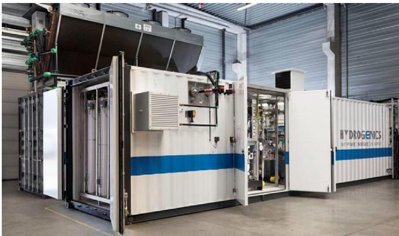
Fig. 3.45- HyLYZER 400/30 con una potenza assorbita di 2 MW
