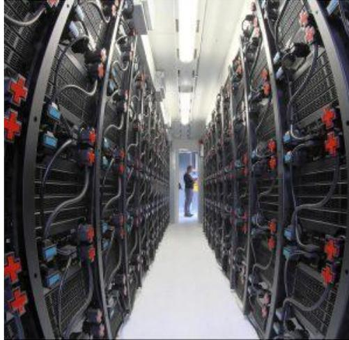
Fig. 3.35– Storage (BESS) interno del container
