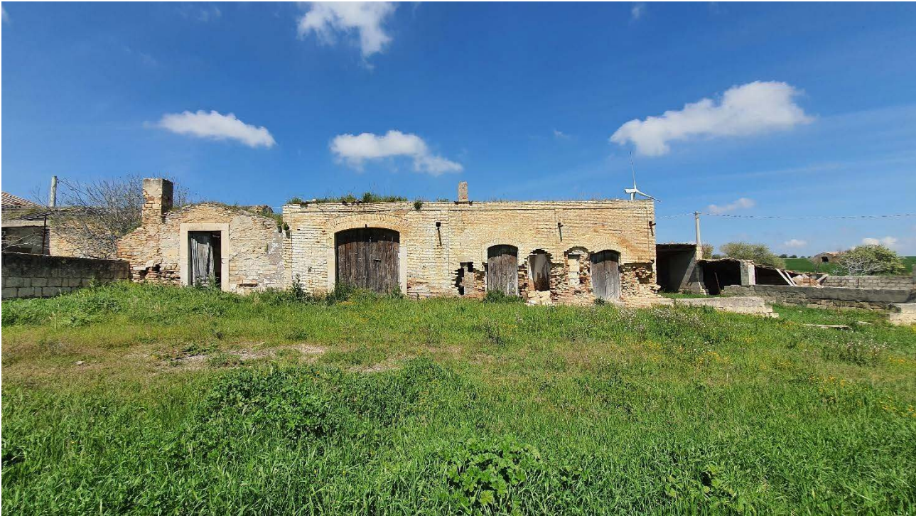
Fig 5.9 – Immobile n.3 Vista SE
