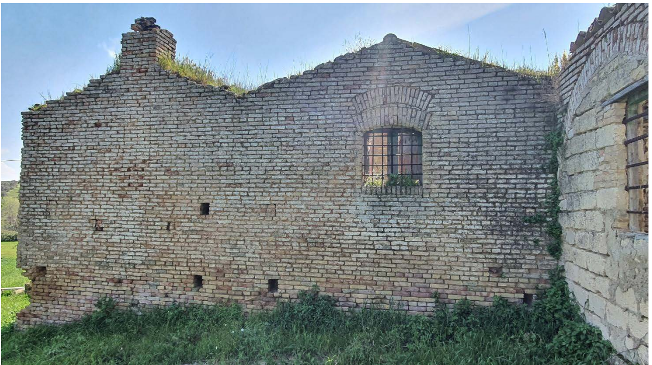
Fig 5.20 – Immobile n.3 Vista Interna corte Nord
