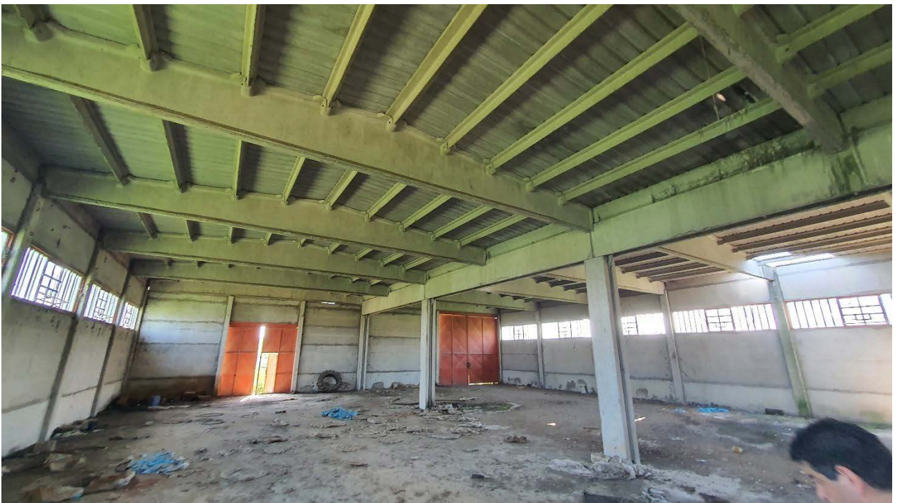
Fig 5.8 – Immobile n.2 Vista Interna
