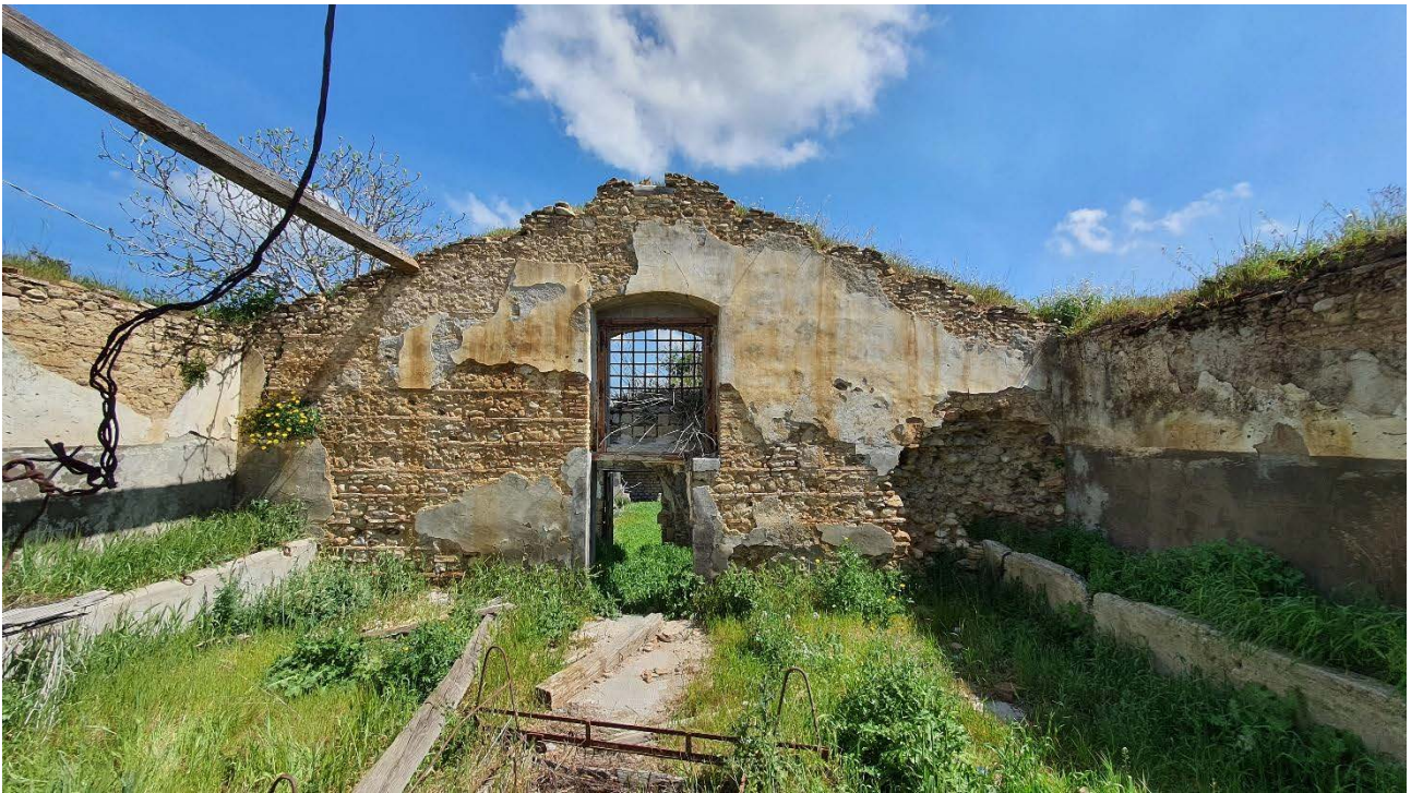
Fig 5.18 – Immobile n.3 Vista Interna
