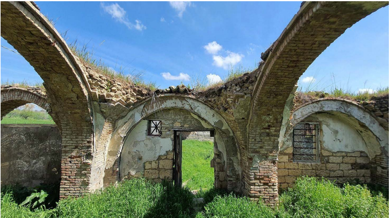
Fig 5.16 – Immobile n.3 Vista Interna
