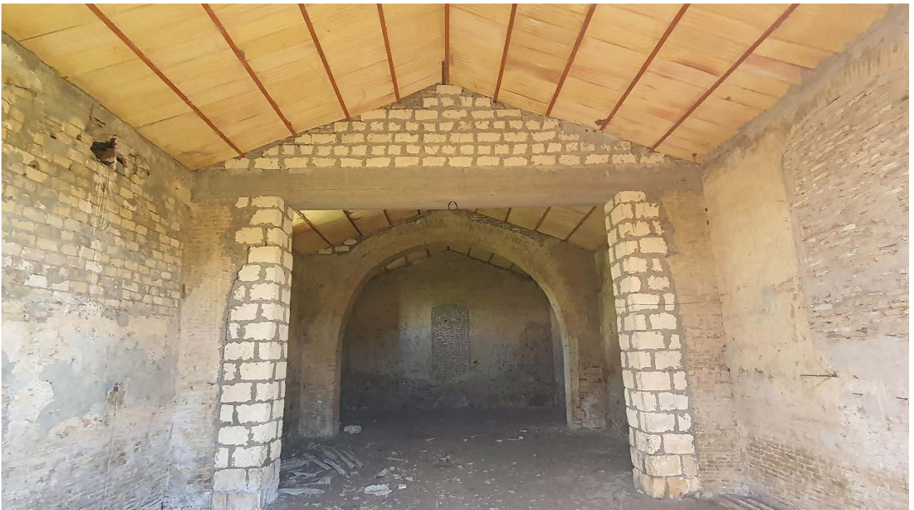
Fig 5.14 – Immobile n.3 Vista Interna
