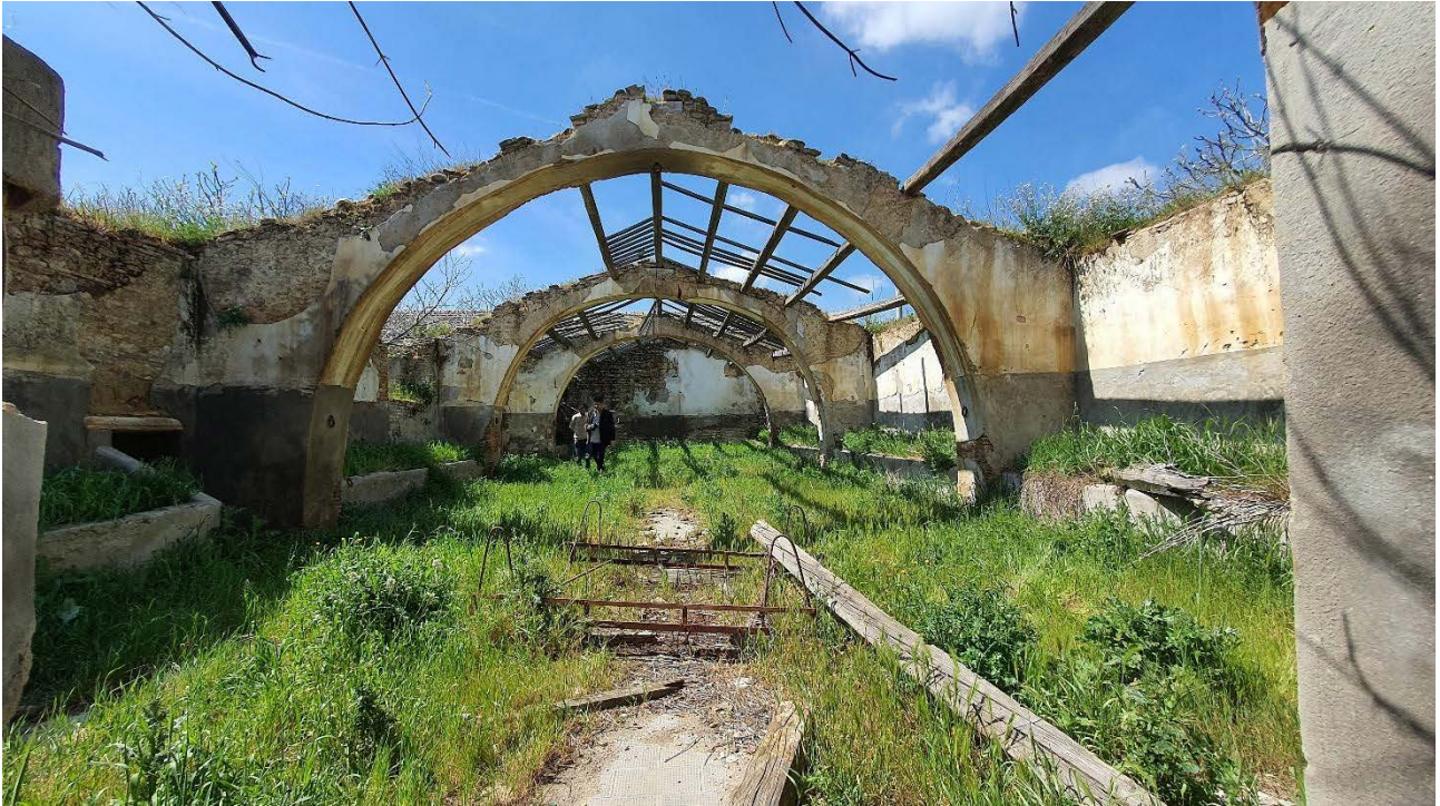
Fig 5.17 – Immobile n.3 Vista Interna
