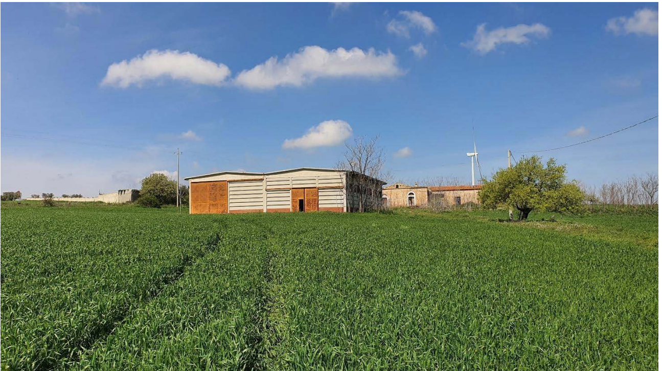
Fig 5.6 – Immobile n.2 Vista SE
