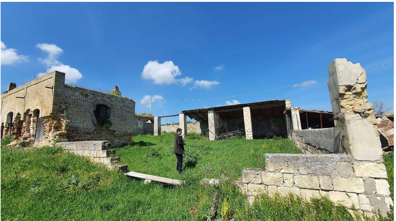
Fig 5.10 – Immobile n.3 Vista SO
