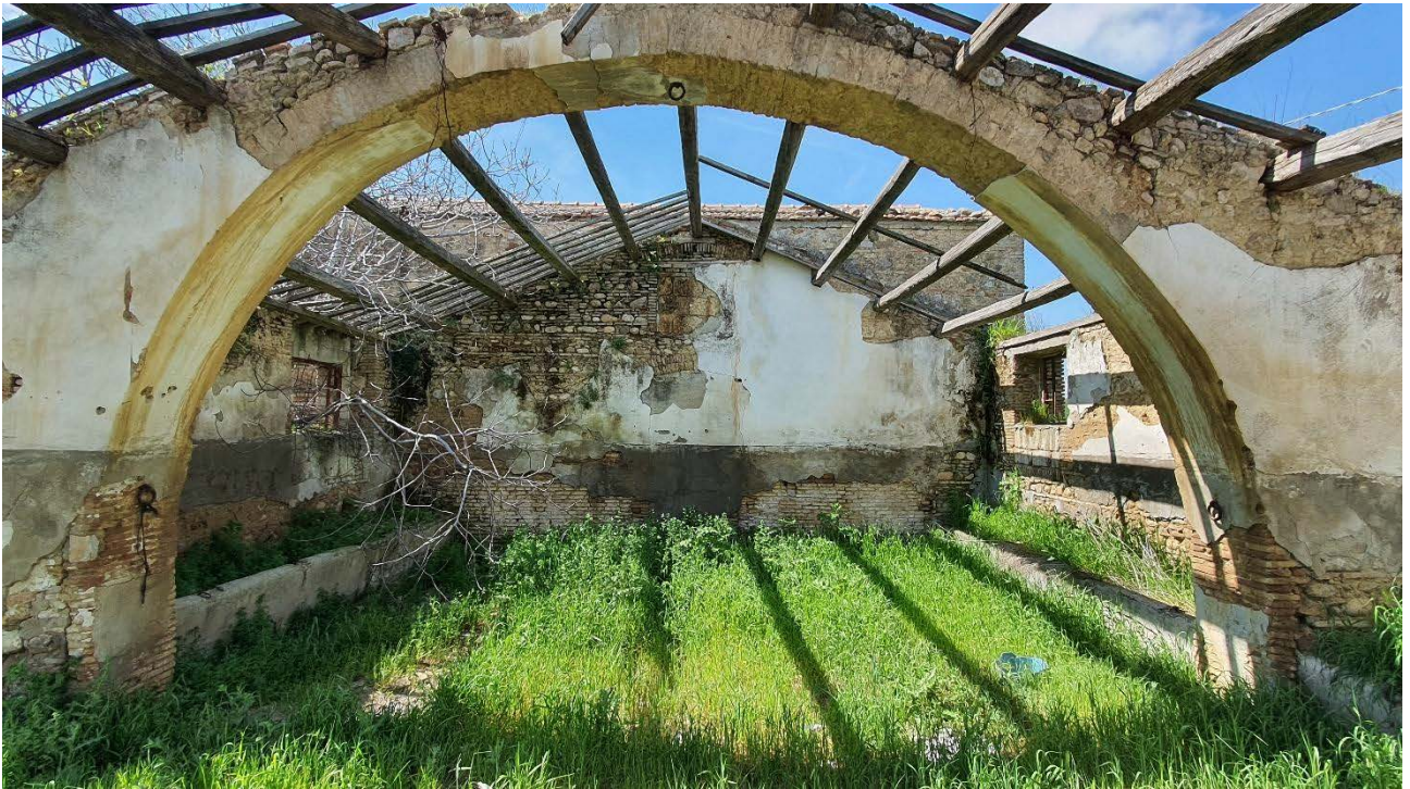
Fig 5.19 – Immobile n.3 Vista Interna
