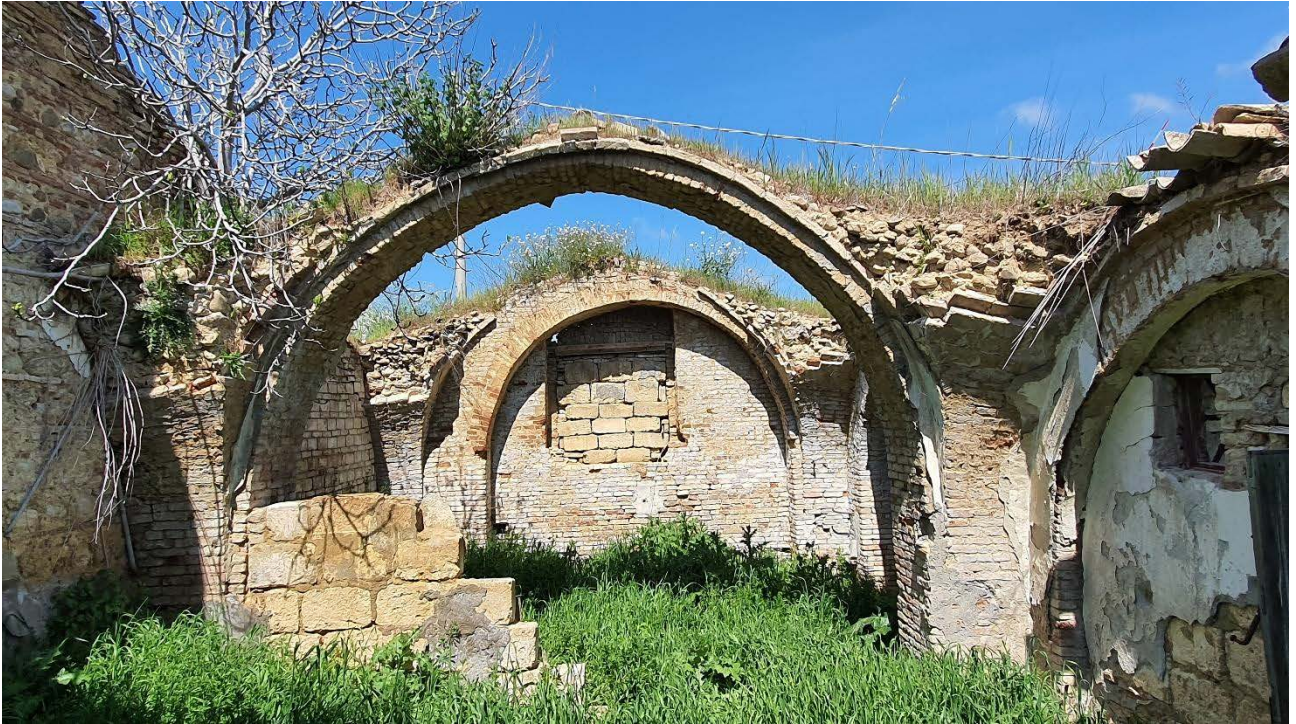
Fig 5.15 – Immobile n.3 Vista Interna
