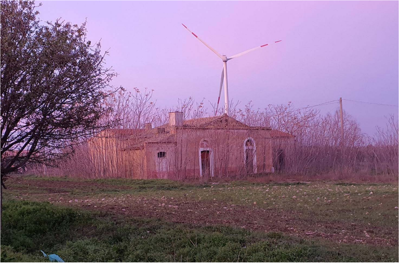
Fig 5.1 – Immobile n.1 Vista SO
