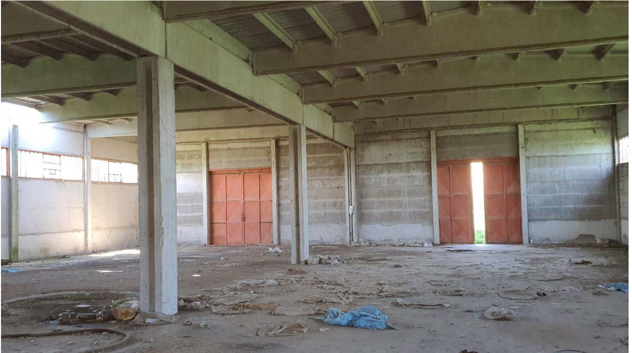
Fig 5.7 – Immobile n.2 Vista interna
