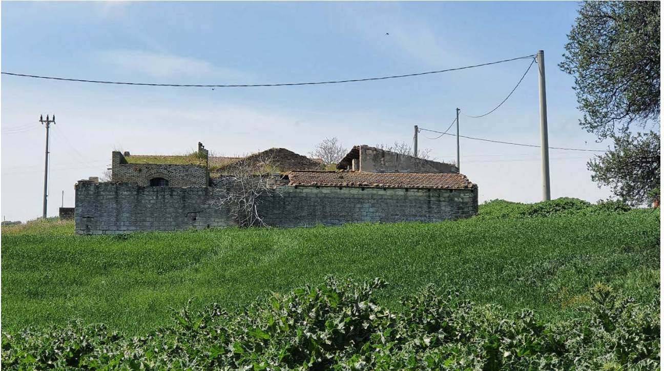
Fig 5.11 – Immobile n.3 Vista E
