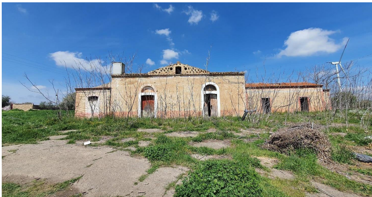
Fig. 5.2 – Stato attuale delle Masserie Capo dell'Acqua
