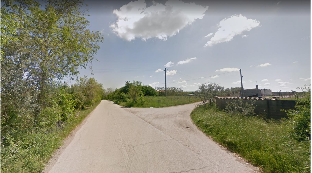
Fig. 3.4: Strada di accesso NO
