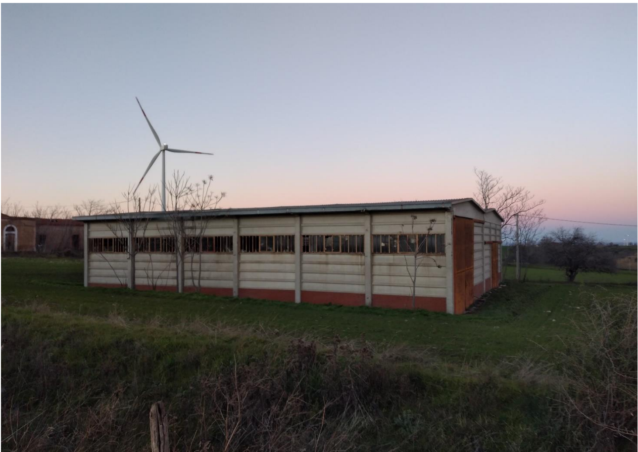
Fig. 3.7: Edifici esistenti lato Ovest su tratturo (Ovest)
