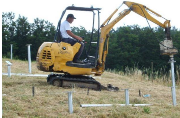
Figura 2: Sistema di ancoraggio al suolo denominato "T-Block"
